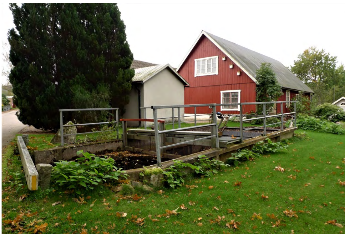
Figur 19. Intagsgaller till den kulverterade intagskanalen. Den röda byggnaden är den gamla kvarnbyggnaden från 1800-talet och längst till höger skimtar en grå gavel tillhörande kraftverket från 2001.
