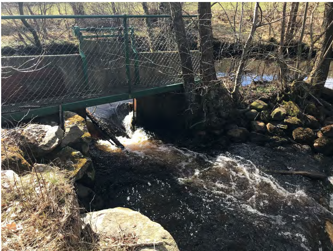
Figur 23. Lucka där vatten avleds till intagskanalen, intagskanalen i bakgrunden och naturfåran i förgrunden, punkt 1 i kartskissen.
