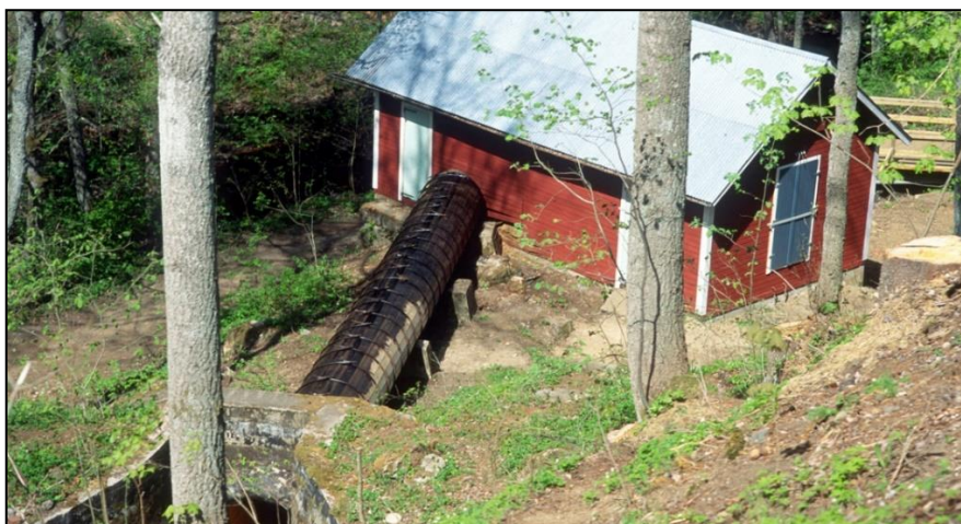
Figur 16. Huluhammar kraftstation med vattentub. Den sista bevarade kraftstationen i drift utmed Tabergsåån (2022).
