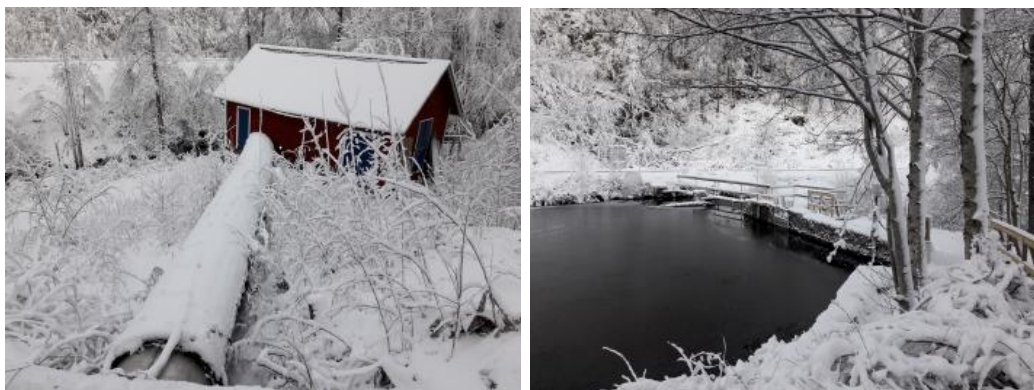
Figur 10. Intagstub och kraftverksbyggnad, Huluhammar vattenkraftverk. Figur 11. Dammen vid Huluhammar. Från vänster sett, Skibord, bottenlucka, utskovslucka, intagslucka till inloppskanal till kraftverk (intagsluckan belägen precis bakom träden närmast i bild). Foto: Länsstyrelsen i Jönköpings län 2019-01-10.
