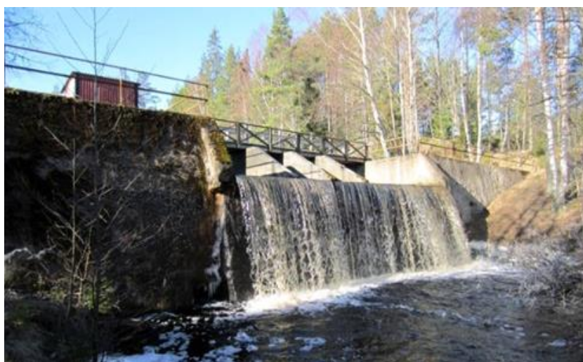
Figur 18. Månsarps södra masugnsdamm med dammfall.
