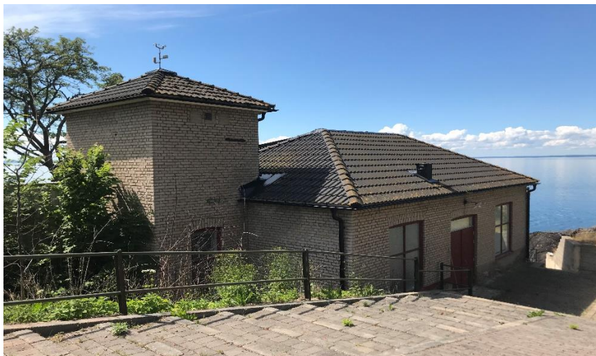
Figur 12. Orrnäs kraftstation vid Vätterns strand.
