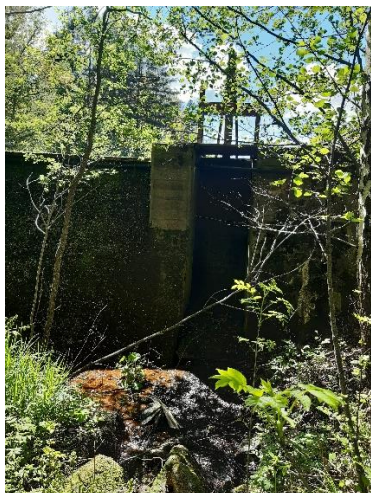
Figur 10. Till vänster. Flodutskov vid Häldelholms kraftverksdamm, sedd från nedströms-sidan. Foto: Länsstyrelsen 2021-05-28. Figur 11. Till höger. Häldelholms Pelton-turbin inne i kraftstationen. Foto: Länsstyrelsen 2021-05-28.
