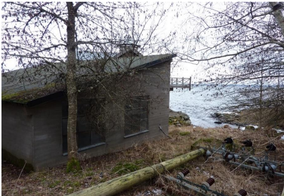
Figur 16. Häldeholms nya kraftstation från 1946, vid Holmåns mynning i Vättern.
