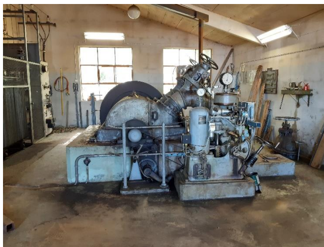
Figur 10. Till vänster. Flodutskov vid Häldelholms kraftverksdamm, sedd från nedströms-sidan. Foto: Länsstyrelsen 2021-05-28. Figur 11. Till höger. Häldelholms Pelton-turbin inne i kraftstationen. Foto: Länsstyrelsen 2021-05-28.
