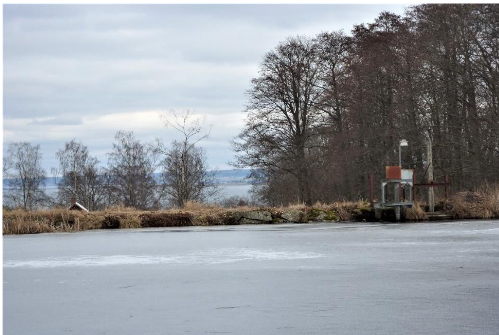
Figur 15. Häldeholms norra del av dammen med utskov och utloppstub ner mot Häldeholms gård och kraftstationen vid Vättern som skymtar med Visingsö i öster.
