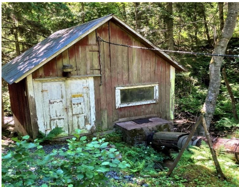
Figur 148. Sågfallets kraftstation med tilloppstub.
