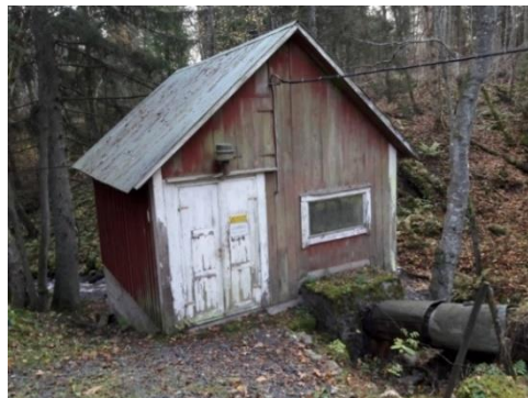
Figur 10. Naturfåran (Sågfallet) och inloppstubb i trä. Figur 11. Sågfallets vattenkraftverk, kraftstationen (foto: Länsstyrelsen i Jönköpings län 2019-10-25).
