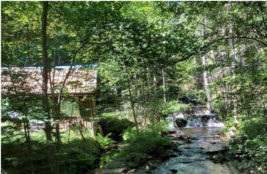
Figur 126. Fagerhults kraftstation med tilloppstub från dammen på andra sidan byggnaden.
