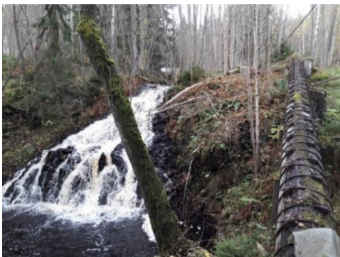
Figur 10. Naturfåran (Sågfallet) och inloppstubb i trä. Figur 11. Sågfallets vattenkraftverk, kraftstationen (foto: Länsstyrelsen i Jönköpings län 2019-10-25).
