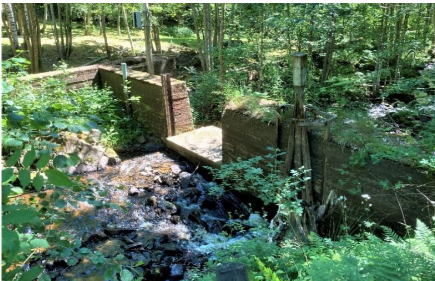
Figur 137. Sågfallets kraftverksdamm, genombruten med fritt flöde.
