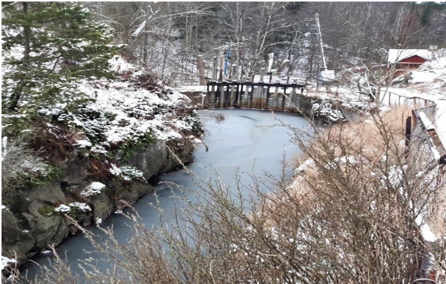
Figur 14. Dammen med utskov och tub till kraftstationen via sprängd kanal.
