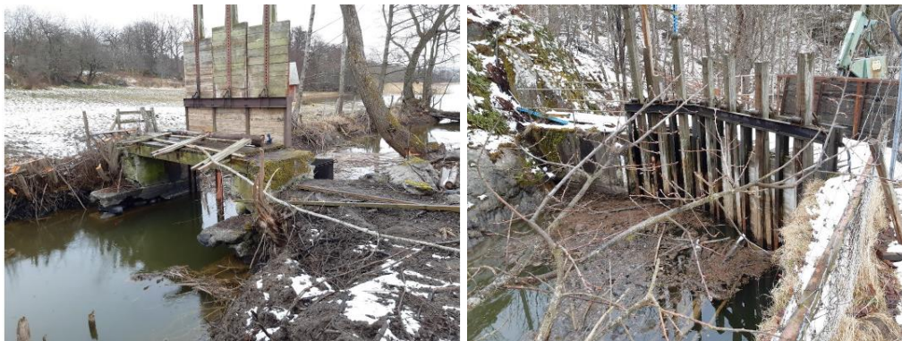
Figur 8. Edeskvarna vattenkraftverk och landsjöns utlopp. Betong utskov vid Landsjöns utlopp. Figur 9. Intagsdamm med intag till tub och utskov till torrfåra. (foto: Länsstyrelsen i Jönköpings län (2022-04-07)).
