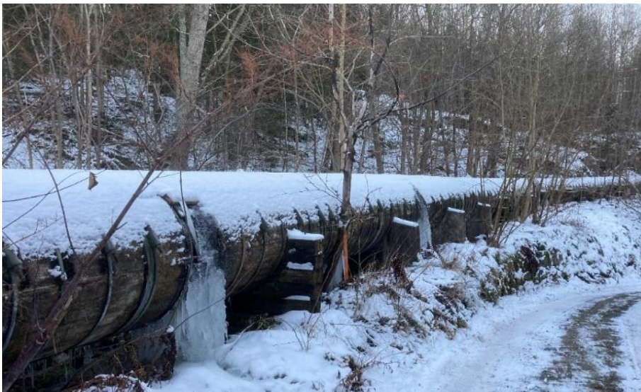
Figur 15. Vattentuben från kraftverksdammen via ravinen ner mot kraftstation.
