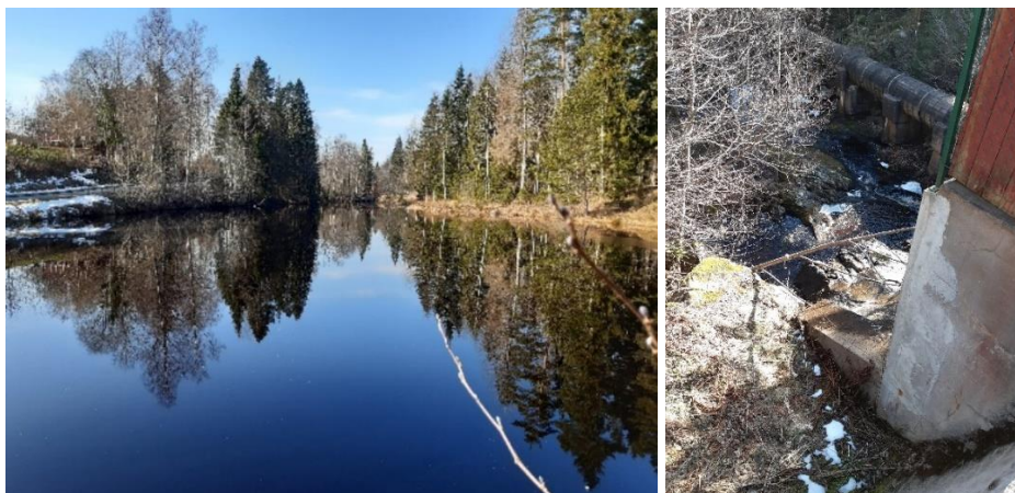
Figur 12. Vy över Hulebodammen. Figur 13. Hulebo kraftstation till höger i bild, med tuben synlig längst upp i bild. Foto: Länsstyrelsen 2022-03-21.
