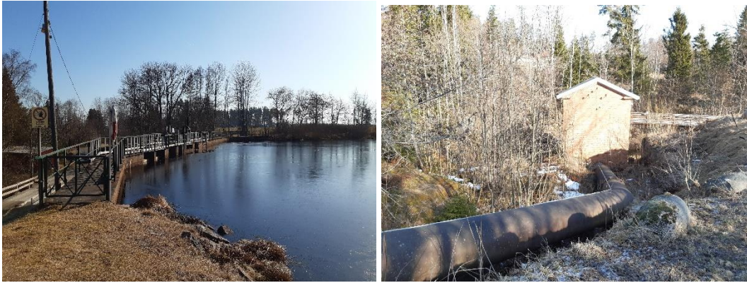
Figur 16. Klerebodammen med utskov. Figur 17. Tub till vänster i bild som leder in till kraftverksstationen. Foto: Länsstyrelsen 2022-03-21.
