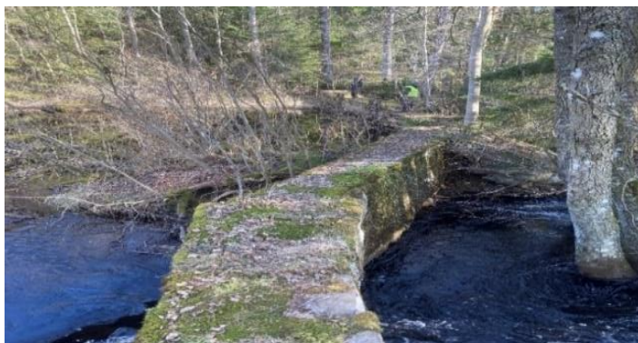
Figur 27. Igenväxt damm med genombrotet parti.
