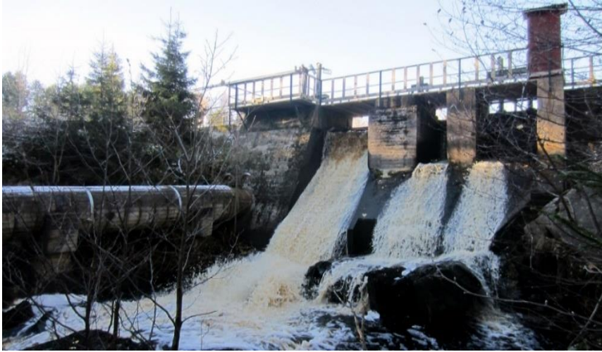
Figur 22. Fördämning till Hulebo damm med tub till Hulebo kraftstation.
