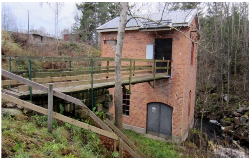
Figur 21. Klerebo kraftstation. Tegelbyggnad i två våningar. Klerebodammen skymtar uppe till vänster i bild.
