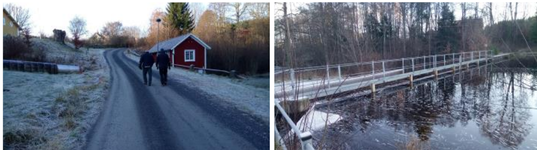
Figur 10. Aledal kraftstation. Till vänster inloppstubb, till höger kraftstationen med turbiner och generatorer. Figur 11. Aledal damm, utskovet sett från uppströmsidan. Inlopp till tub längst till vänster, därefter det cirka 30 meter breda skibordet med sättare. Cirka 20 meter höger om tubinloppet finns ett bottenutskov med spetlucka. (Foto Länsstyrelsen 2017-12-04.)
