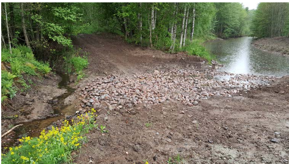
Station 2 BH (vägtrumma ersattes med stentröskel 2017)
