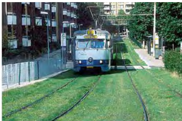
Figur 14: Exempel på faktisk grönstruktur I Göteborg har kommunen arbetat vegetation i anslutning till stadens spårvagnsnät. Effekten är förutom fuktbevarande även reducerade bullerstörningar från spårvagnarna (Foto: Jan Brandberg, Göteborgs Stad)
