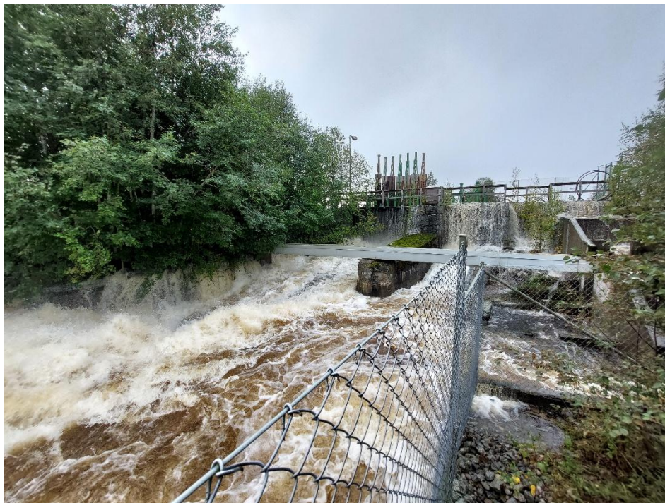
Nedströms dammen vid utloppet av Mörtsjön 250908 kl 17.10. Dammluckorna har öppnats ca 40 minuter tidigare. Notera att vattnet rinner över dammkrönet. Foto: Länsstyrelsen Västernorrland
