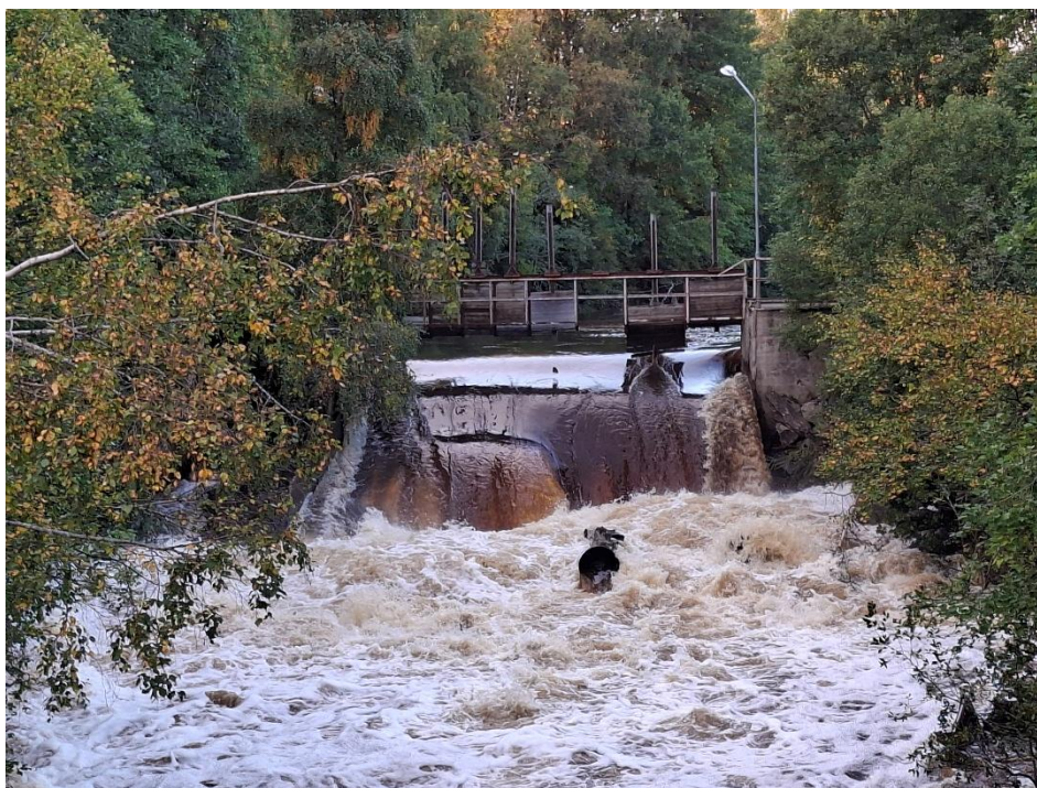
Nedströms dammen i Näsån, 250908, kl 1830. På bilden syns huvudöppningen i dammen, men det finns även ett mindre överfallsutskov till höger i bild där några plåtar rivits lös. Foto: Länsstyrelsen Västernorrland
