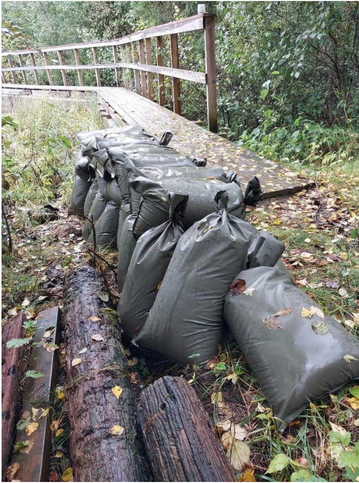
Sandsäckar som förstärkt sidorna för överströmning vid Grössjön, Kramfors kommun, 20250916. Foto: Länsstyrelsen Västernorrland
