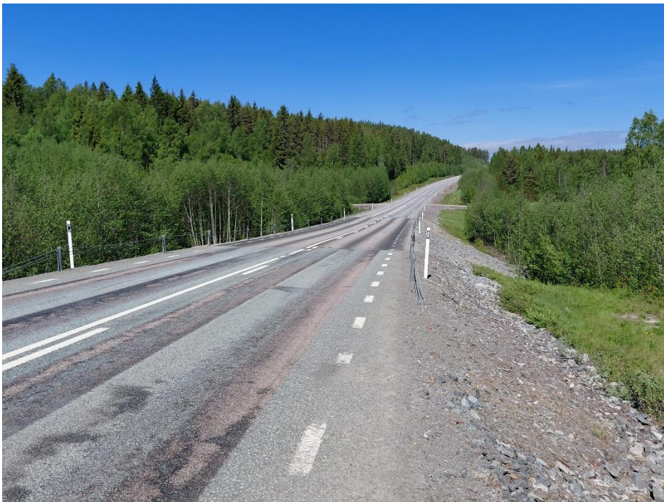
Riksväg 90 vid Kyrkdal efter återställning, 20260602. Foto: Länsstyrelsen Västernorrland
