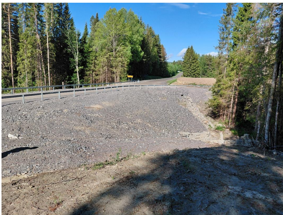
Väg 738, Judeby, återställd väg 20260602, Foto: Länsstyrelsen Västernorrland
