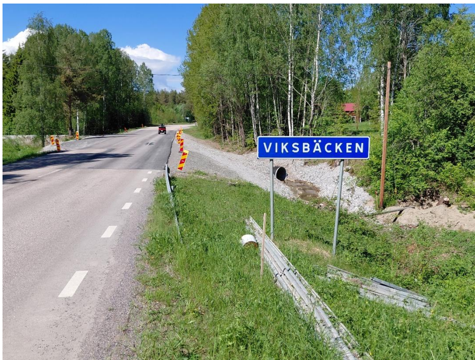
Väg 786 vid Viksbäcken efter genomförd återställning, 20260602. Foto: Länsstyrelsen Västernorrland
