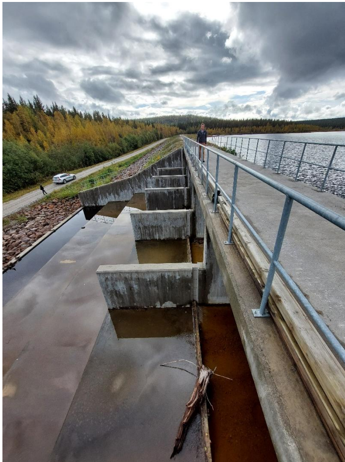
Överfallsutskovet på Agnsjönsdammanläggning, 250916. Foto: Länsstyrelsen Västernorrland
