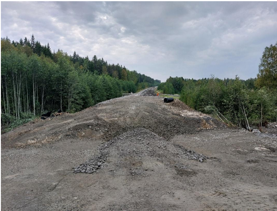
Riksväg 90 vid Kyrkdal under reparationsarbetet 20250911, Foto: Länsstyrelsen Västernorrland
