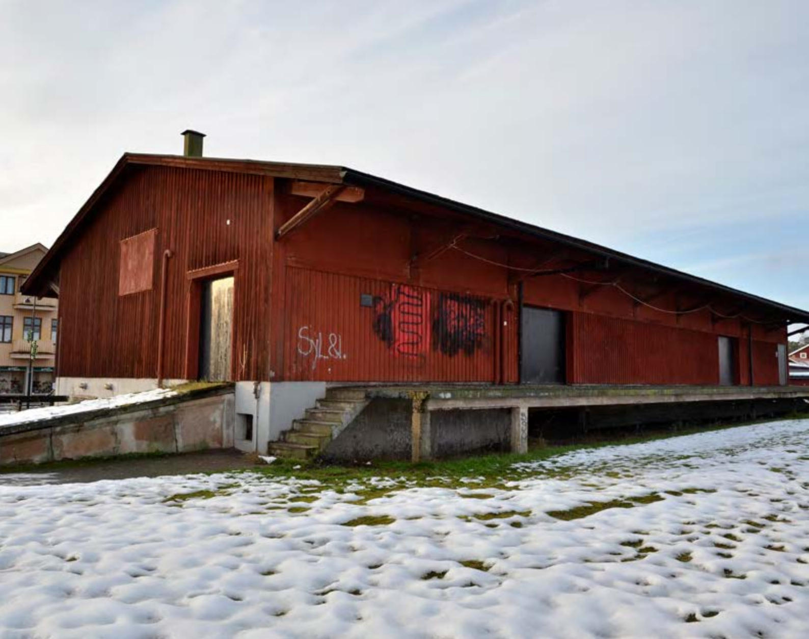
Godsmagasinet i Gnesta hade breda lastkajer på tre sidor och kraftigt utskjutande tak som skyddade lastkajerna. Foto: Eva Wockatz/Sörmlands museum (CC BY).
