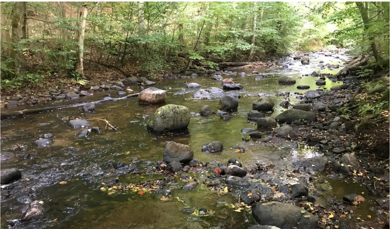
Bild: Exempel på blockrestaurerad stömsträcka nedströms Hallamölla i Verkeån. Block och stenar har tagits från rensvallar längsmed strandkanten och lagts tillbaka i fåran.
