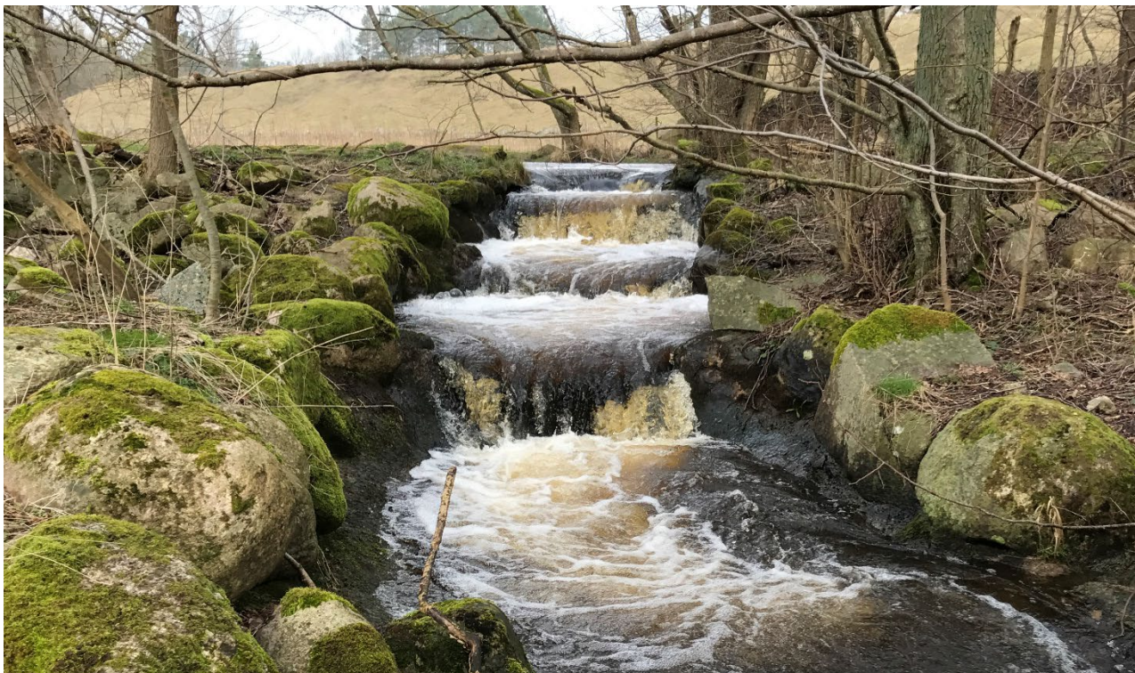
Bild: Exempel på partiellt vandringshinder i Verkeån, i form av kammartrappa. Här finns möjlighet att återskapa fria vandringsvägar.
