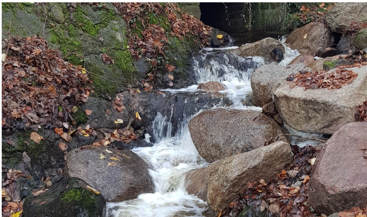
Bild: Exempel från Klammersbäck på hur vandringshinder i form av kammartrappa har åtgärdats, genom att bäckbotten vid och nedströms kammartrappan har byggts upp med block och stenar.
