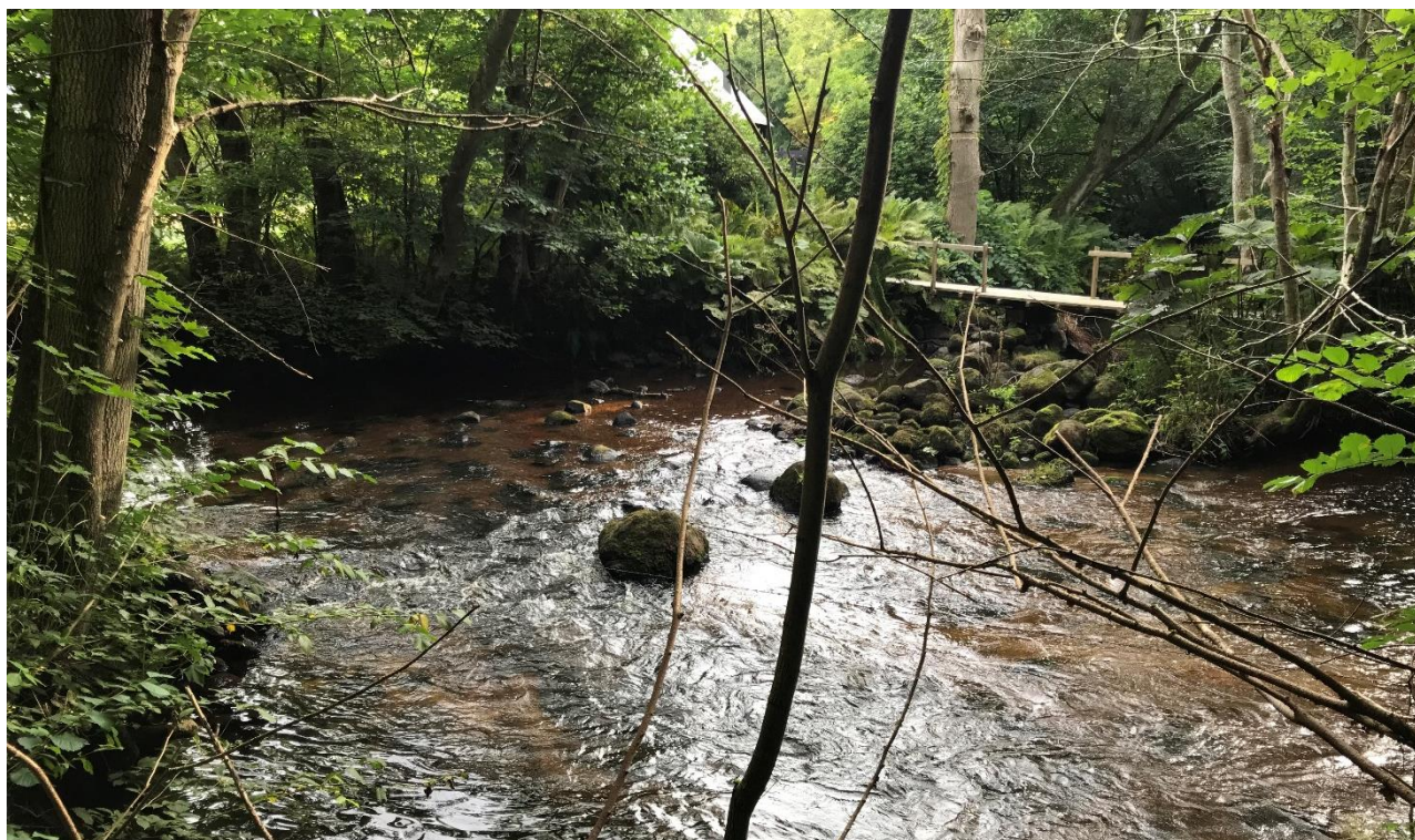
Bild: Exempel från Verkeån på hur vandringshinder i form av ett stendämme har åtgärdats, genom att sänka av dämmet och återföra block och stenar från dämmet till åfåran.
