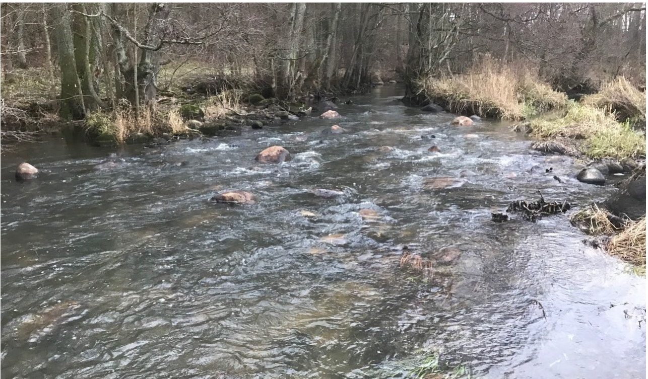
Bild: Exempel på blockrestaurerad stömsträcka vid Gantofta i Råån. Block och sten har tagits från rensvallar längsmed strandkanten och lagts tillbaka i fåran.
