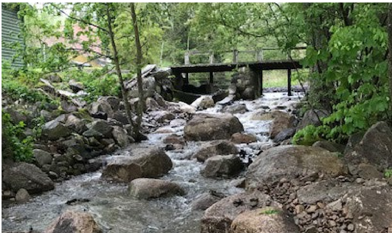
Bild: Exempel på ett åtgärdat vandringshinder vid Dämmemölla i Segesholmsån. Vandringshindret åtgärdades genom att anlägga en ramp av sten (s.k. överlöp) nedströms avsänkt betongtröskel.
