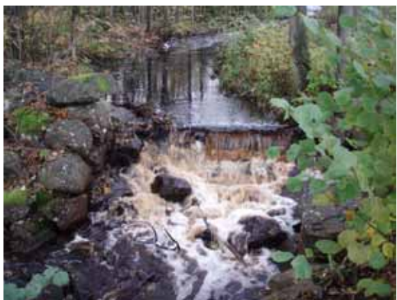
Figur 21. Vandringshinder nr 2 vid vattendragssträcka 5 i centrala Osby utgör ett partiellt vandringshinder både för öring och men definitivt för mört. Den vänstra av två fåror som båda är fördämda. Vandringshindret utgör även nyckelbiotop av typen "kulturmiljö i anslutning till vattendrag". Fotograf: Jonas Johansson, Calluna AB.
