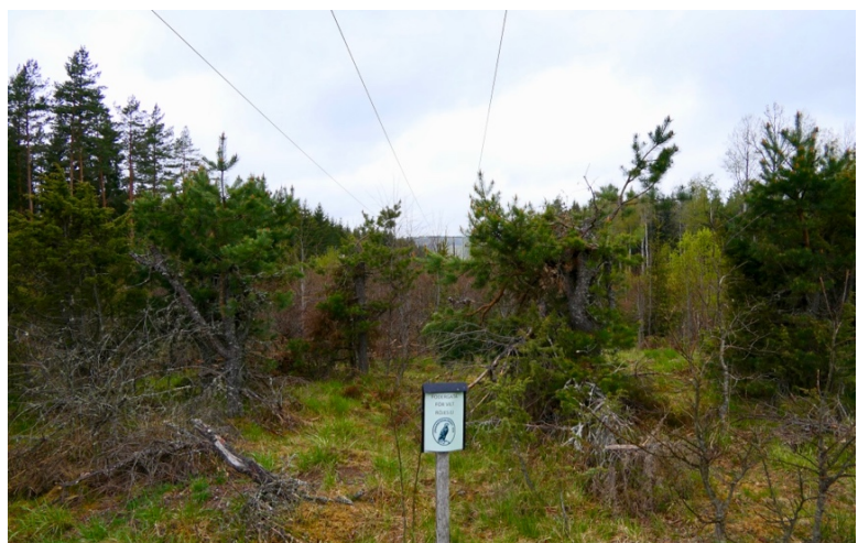
En skylt markerar vilken sträcka av kraftledningsgatan som ett jaktlag tagit på sig att sköta. Detta minskar risken för att allt röjs bort när nätbolaget utför röjning.
