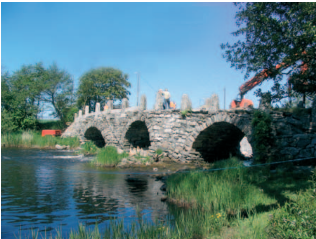
Den gamla stenvalsbron över Rolfsån reparerades under 2004.
