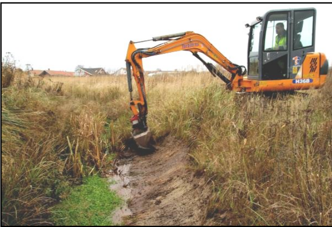
Bild 8 & 9. Kanterna skrapas med hjälp av en 3,5 tons bandgrävare. Möjan lämnas i stort sett orörd i själva vattenfåran. Långenäsviken, november 2011. Foto Kill Persson.
