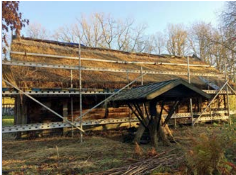
Byte av halmtak på ladugården på Lindekullen i Hyltebruk. Foto: Bo Westman
