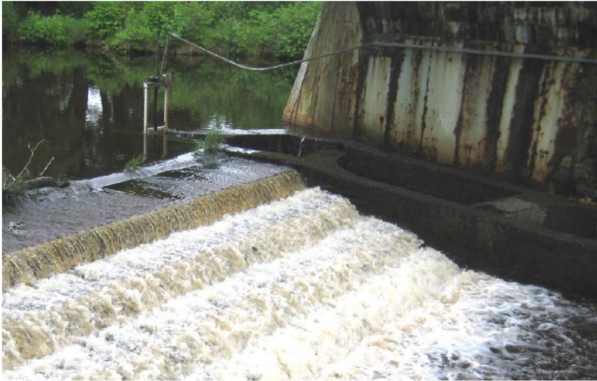
Figur 4. Skibord samt övre delen av fiskvägen.
