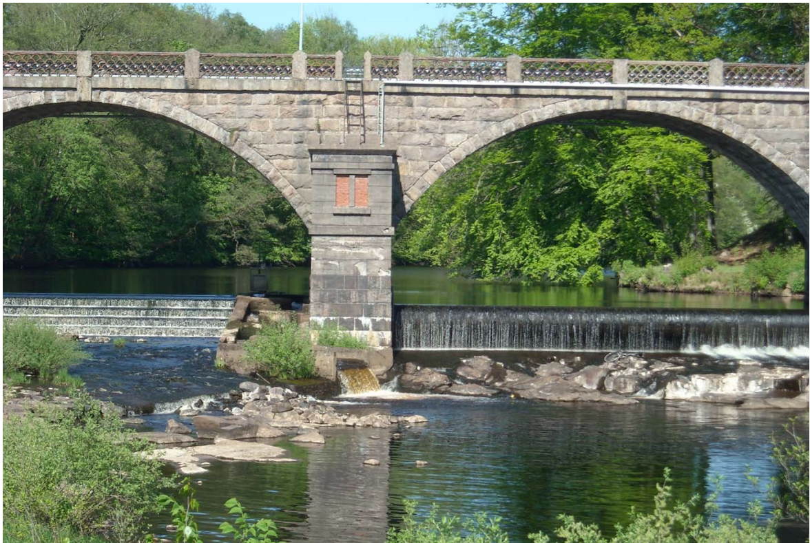
Figur 4. Skibord samt övre delen av fiskvägen.
