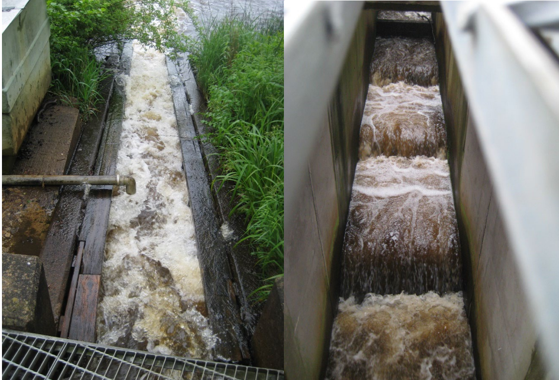
Figur 2. Motströmsränna (t.v) och kammartrappa (t.h) utgör tillsammans den yngre av de två fiskvägarna vid Slotsmöllans kraftverk.
