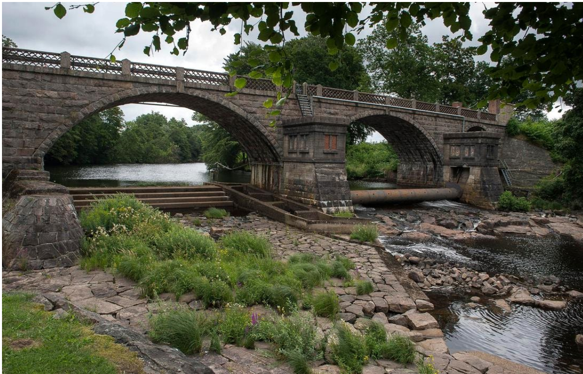
Figur 3. Den äldre fiskvägen utgörs av en slitsränna intill bropelaren i stenvälsbron.
