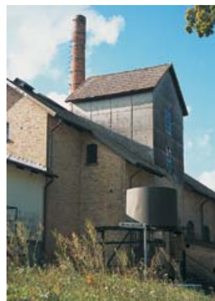
Vid Folkestorps bränneri norr om Maglehem bedrevs sista kampanjen 1971. Det är det enda bränneriet med bevarad utrustning av de hundraåriga gårds- och andelsbrännerier som funnits i Skåne under 1900-talet. Frågan om byggnadsminnesförklaring är under utredning. Foto: Marie Grönvold.
