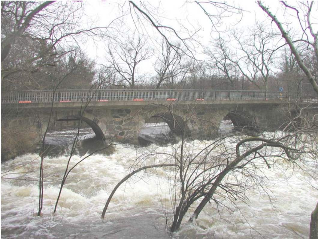
Stenvalvsbro i tre spann, körbanan breddad med betong, Klippans pappersbruk. Foto: Daniel Melchert
