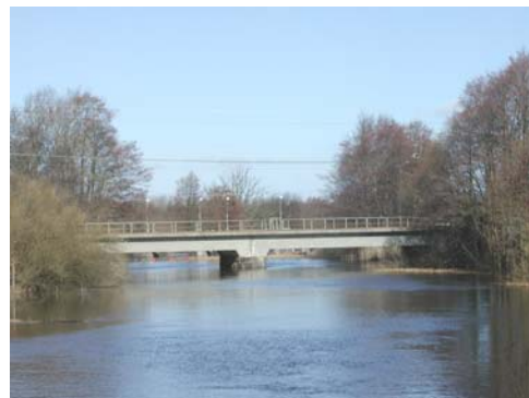
Den äldsta järnvägsbron är också den modernaste: stambanans bro vid Sjöholmen med en överbyggnad i betong från 1974. Foto: Daniel Melchert
