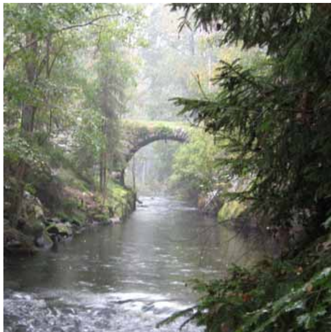
Figur 13. Strukturelement, stenbro över Edre ström på A-sträcka 4. Foto: Jan Pröjts.
