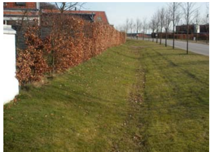
Exempel på svackdike i Maria park, Helsingborg (Foto: Pär Persson)
