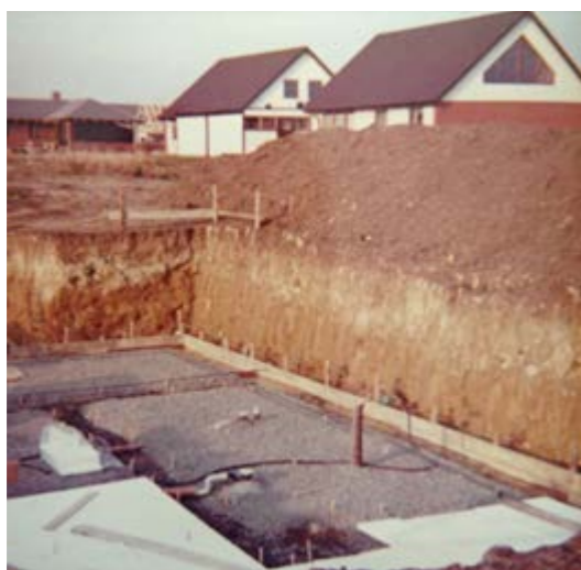
Bild 1 Grundläggning för småhus i Skåne, 1970-tal. Foto: Rolf Persson
