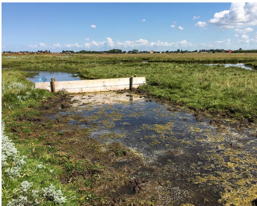
Dämme vid Vellinge ängar. Tillverkat och uppsatt av Peder Clase. Under vårar (maj-juni) med långvariga högtryck utan nederbörd är dessa dämmen guld värda! Foto: Mattias Ullman
