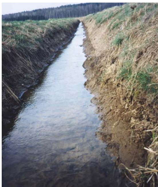
Figur 20. Raka jordbruksdiken fungerar bra som vattenledare men mycket dåligt om naturligt reningsverk.
