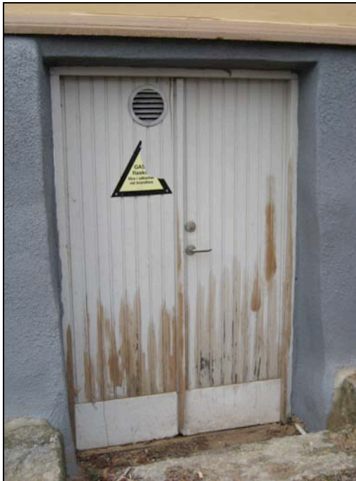
Slutbesiktning 061120. Målningen godkändes inte eftersom det inte var färdigt, kladdigt målat i övergångar samt att rondellspår från slipen var synliga i panelen.
