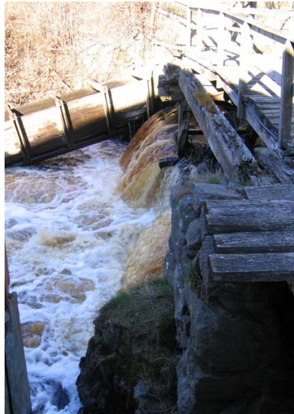
Figur3. Karta och fotografi på vandringshindret vid Björstorp i Bräkneån, befintlig denilränna syns delvis i borte änden av dammvallen. Källa: www.gis.lst.se , foto: T. Nydén.
