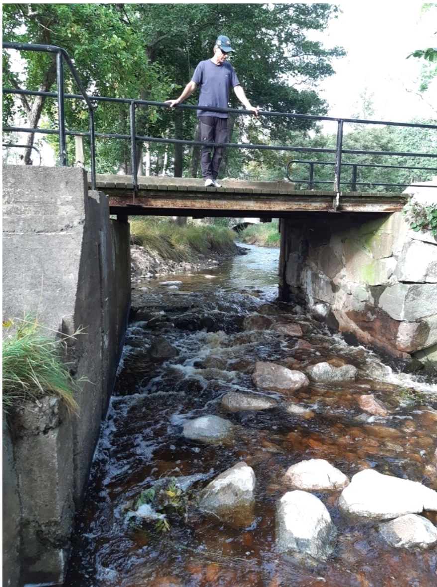
Figur 3. Åtgärdat vandringshinder genom uppfyllning, Bubbetorps gård, Silletorpsån. Fundamenten har sparats för att bevara kulturmiljön. Foto: Andreas Skarmyr.
