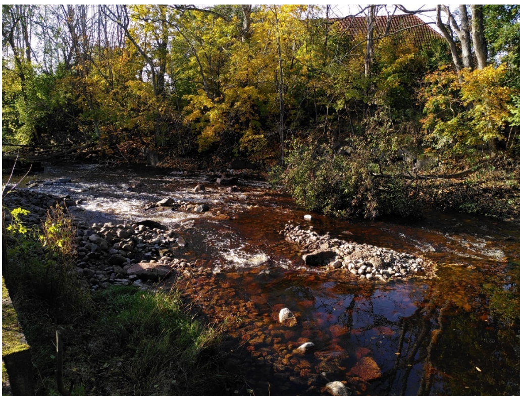
Figur 1. Återställd strömsträcka efter utrivning av damm vid Vörta kvarn, Nättrabyån. Foto: Andreas Skarmyr.
