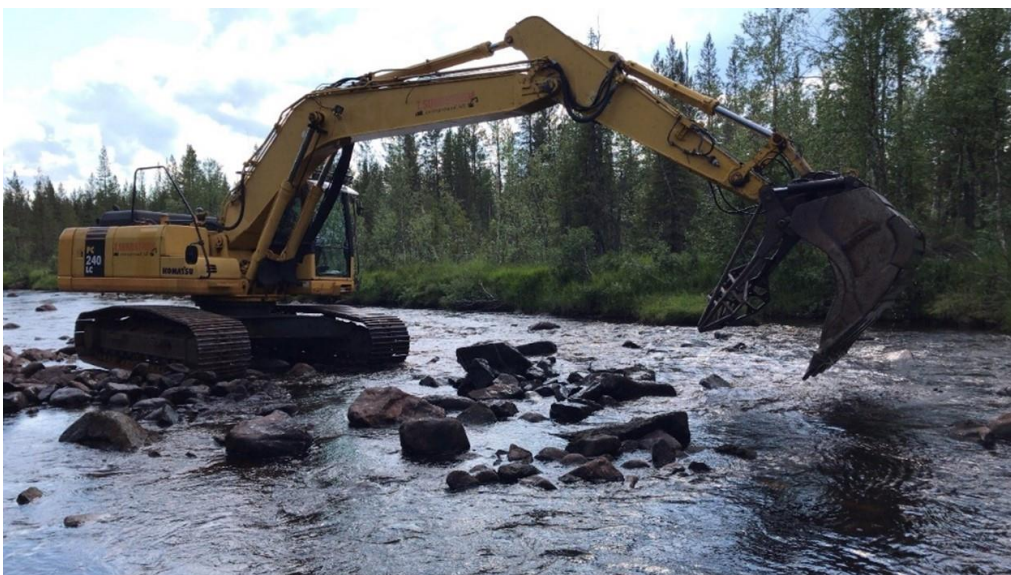
Figur 12. Bandgrävmaskin används för att återställa vattendrag.
