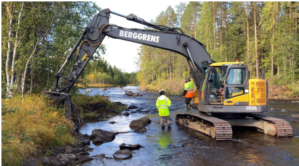
Figur 2. Exempel på biotopåterställning genomförd med grävmaskin. Foto: Länsstyrelsen i Norrbottens län
