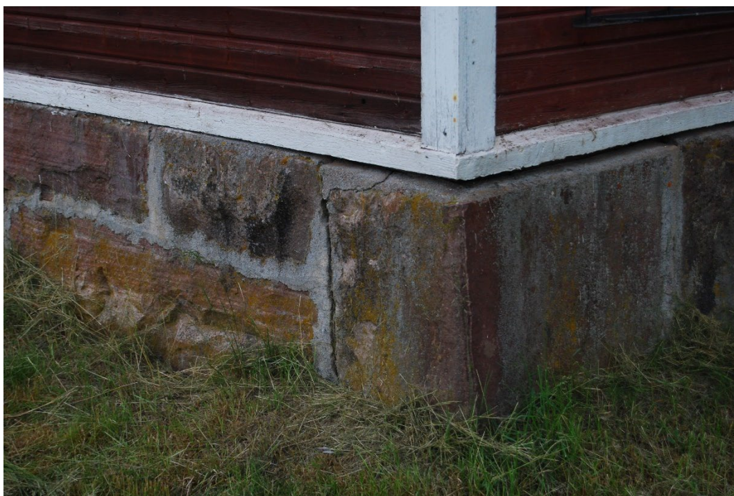
Figur 7. Grundens sandstensblock kommer troligtvis från ett närbeläget stenbrott. Foto: Anders Gottberg, Länsstyrelsen i Dalarnas län.
