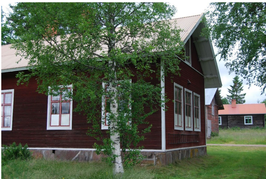
Figur 4. Skolhusets fasader är målade med röd slamfärg. Notera taksprångets dekorativa taktassar. Foto: Anders Gottberg, Länsstyrelsen i Dalarnas län.
