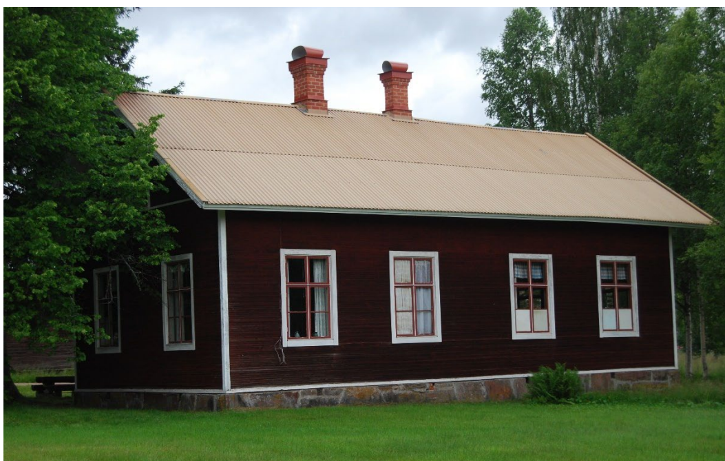
Figur 5. Byggnadens ursprungliga taktäckning av stickspån är bevarad under plåttaket. Foto: Anders Gottberg, Länsstyrelsen i Dalarnas län.
