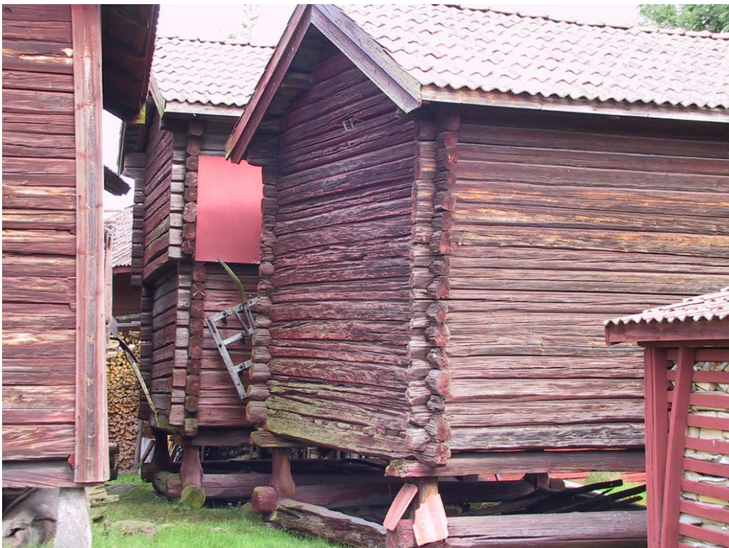
Figur 3. Samtliga härbren är timrade. Foto: Linnea Skog, Länsstyrelsen i Dalarnas län.
