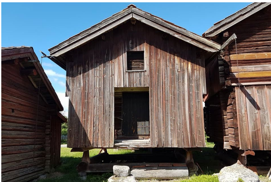
Figur 5. Några härbren har klätts med panel. Foto: Länsstyrelsen i Dalarnas län.
