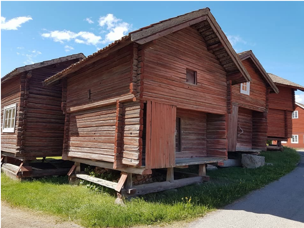
Figur 4. Härbrena är samtliga uppförda i två våningar av rödmålat timmer. Foto: Länsstyrelsen i Dalarnas län.
