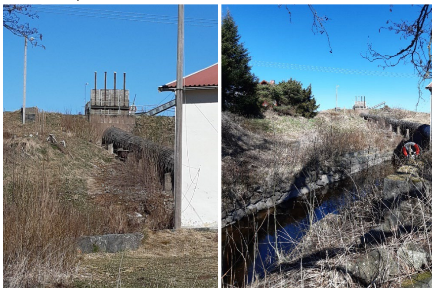
Figur 10. Intaget till den nedre kraftstationen, sett från nedströmssidan. Tuben syns mellan luckorna och stationen. Kraftstationen ses i höger i bild. Figur 11. Utloppskanalen från kraftstationen. Kraftstationen ses i höger i bild. (Foto: Länsstyrelsen i Jönköpings län.)
