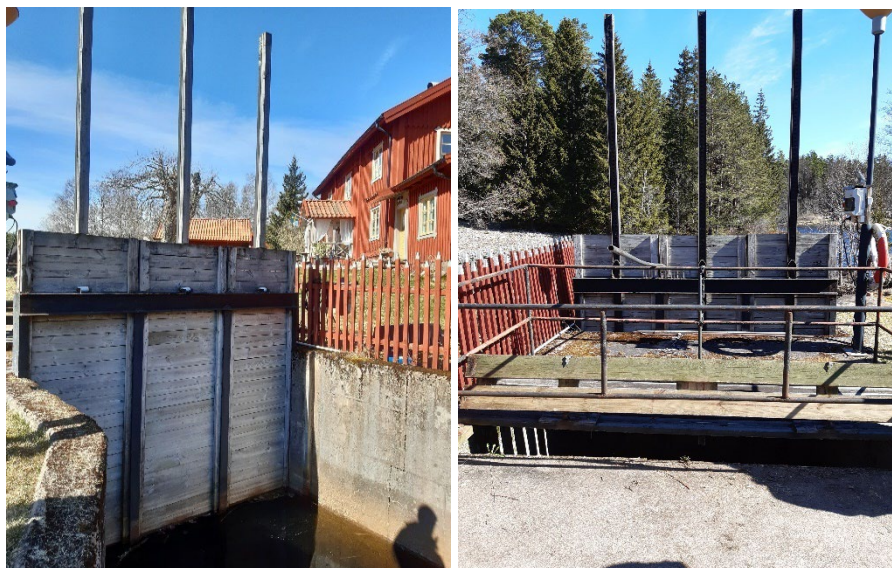
Figur 14. Utskovsluckor Edets kraftverk, sett från nedströmssidan. Figur 15. Utskovsluckor Edets kraftverk, sett från uppströmssidan. (Foto: Länsstyrelsen i Jönköpings län)
