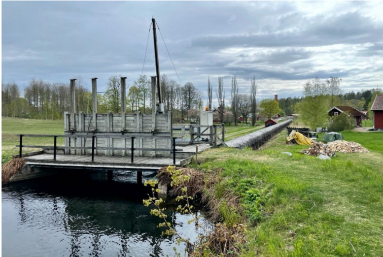
Figur 28. Intaget till Sättra övre kraftverk.
