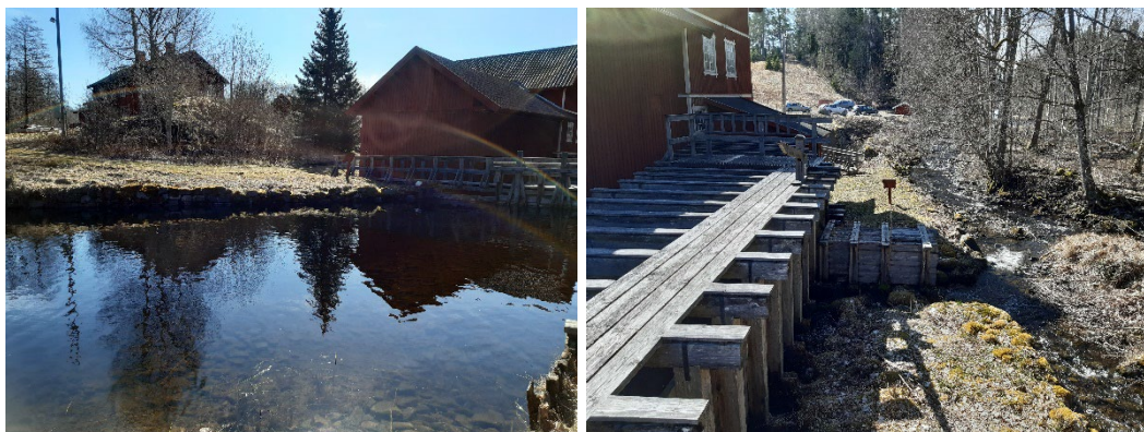
Figur 18. Kvarndammen med Benstampen synlig till höger. Figur 19. Benstampen till vänster med kvarndammens regleringsanordningar och utflödeskanal till höger. (Foto: Länsstyrelsen i Jönköpings län)
