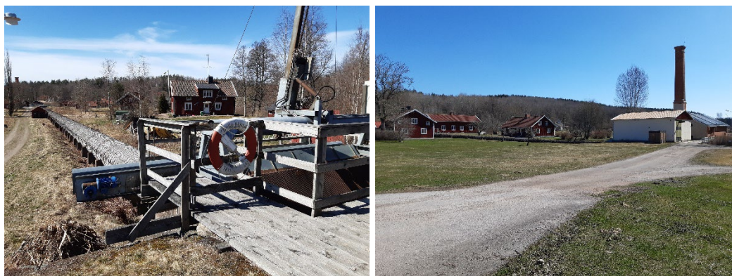
Figur 12. Intagsluckor samt tuben som går från intaget vidare till Sätra övre kraftverk. Uppströms anläggningen går intagskanalen till Sätra Övre vattenkraftverk. Figur 13. Sätra Bruks Övre kraftstation. Tuben syns till vänster om kraftstationen. (Foto: Länsstyrelsen i Jönköpings län)
