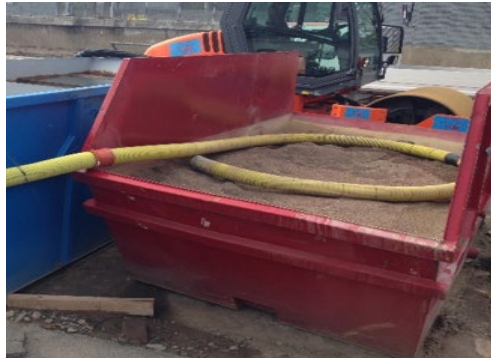
Sandfilter i container. Foto A-C. S. Lember
