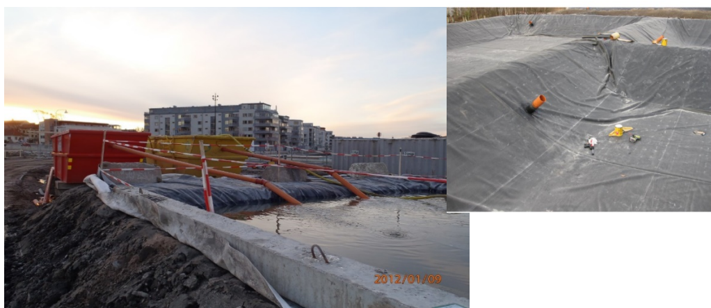
Figur 3.3 Sedimentationsdamm till vänster och uppbyggnad av damm med flera uppsamlingsstrågar till höger. Foto. A-C. S. Lember
