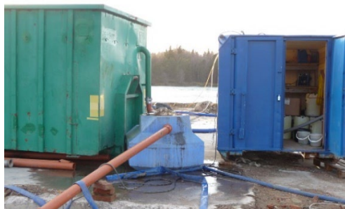
Inblandningstank för flockning. Foto A-K Davidsson
