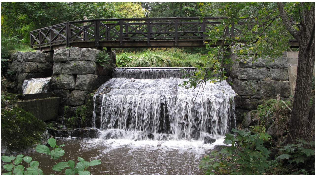
Dammen vid Fors kvarn. Foto: Martin Olgemar
