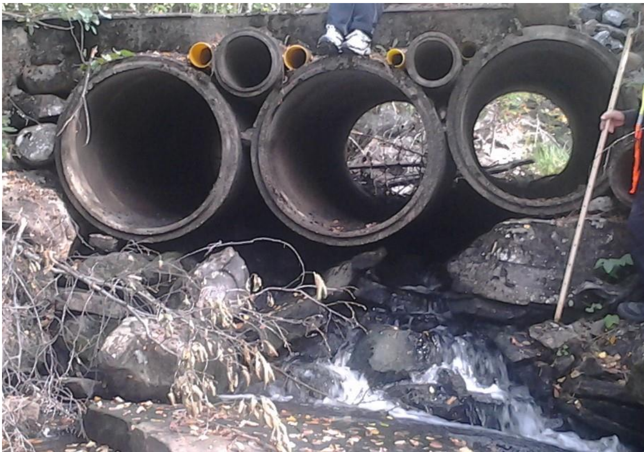
Bild: Vægtrummor i Gisselån nedströms Buadamm. Bild från SAFT-projektet.
