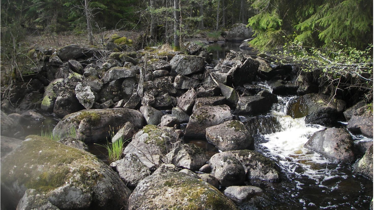
Stendamm i nedre delen av vattendraget som utgör ett partiellt vandringshinder. Peter Gustafsson
