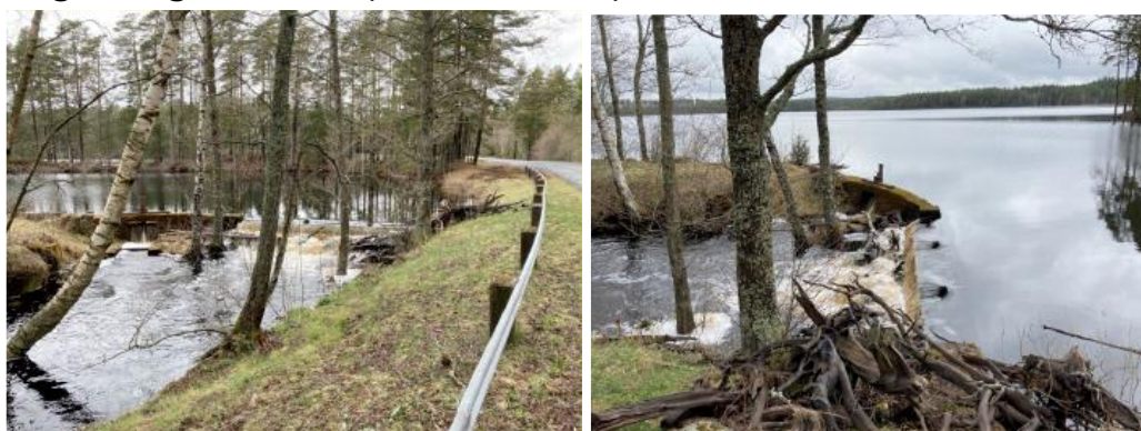
Figur 10. Utloppet vid Hornsjöns regleringsdamm med utskovsluckan till höger i skibordet. Dammfästet vid Hornsjön från sidan. (foto: Länsstyrelsen i Jönköpings län 2021-05-06).
