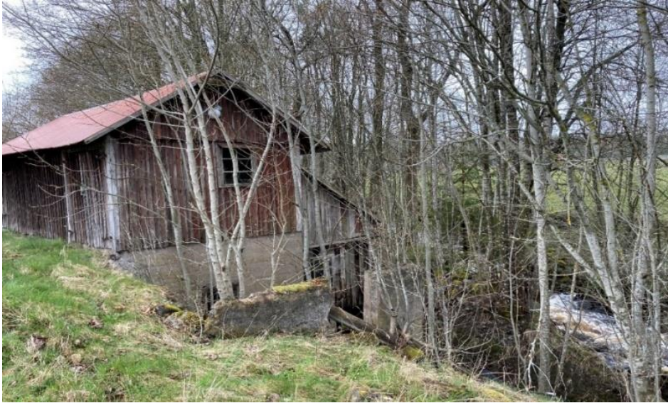
Figur 17. Myrebo kraftstationsbyggnad vid Hornån
