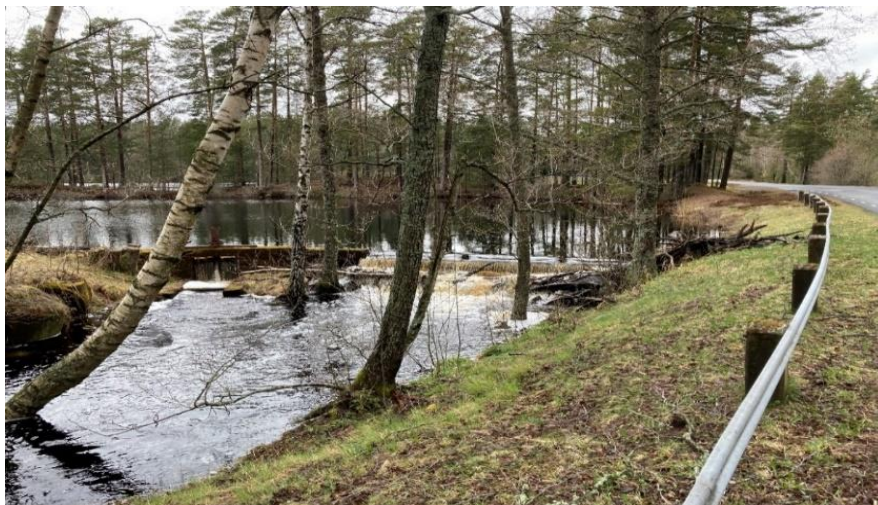
Figur 15. Hornsjöns fördämning vid landsvägen till Gustav Adolfs by.
