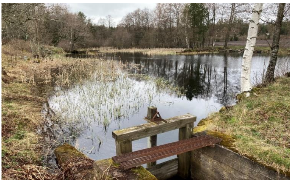
Figur 16. Myrebo damm. Dammvallen utgör även vägbank till närliggande fastighet.
