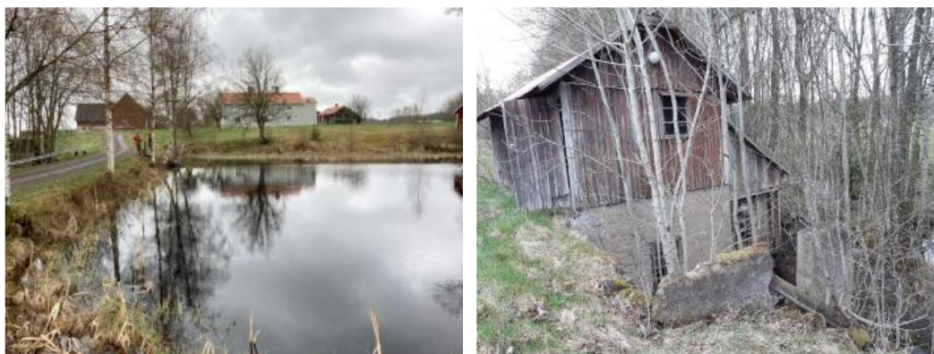
Figur 11. Till vänster: Myrebo kraftverksdamm där dammfästet även utgör väg. Till höger: Myrebo kraftstation sedd från nedströmssidan (foto: Länsstyrelsen i Jönköpings län 2021-05-06).
