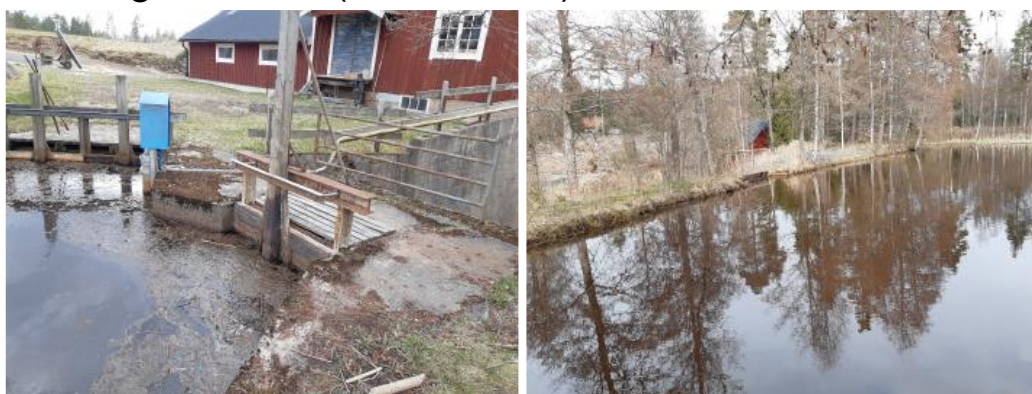
Figur 18. Intaget från kraftverksdammen till kraftstationen vid Konungsö kvarn. Figur 19. Konungsö kvarns kraftverksdamm med flodutskovet synligt mitt i bild. (Foto: Länsstyrelsen 2021-04-29)
