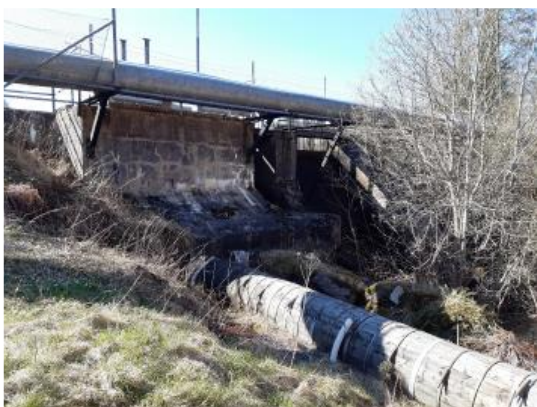
Figur 13. Dammfästet vid Hällstorp nedre vattenkraftverk sett från sidan. Foto: Länsstyrelsen 2021-04-30
