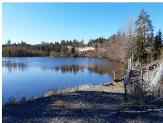
Figur 12. Dammfästet från nedströmssidan vid Hällstorps nedre vattenkraftverk.
