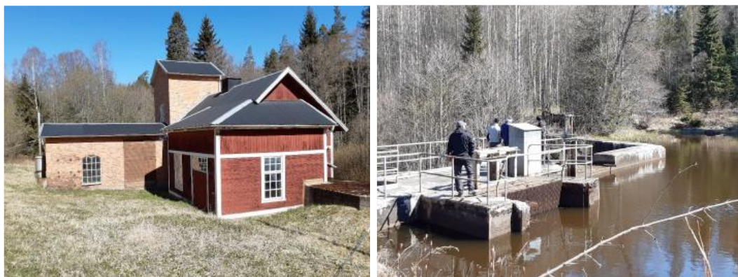
Figur 14. Kraftstationen vid Hällstorp övre vattenkraftverk. Figur 15. Dammfästet från sett
