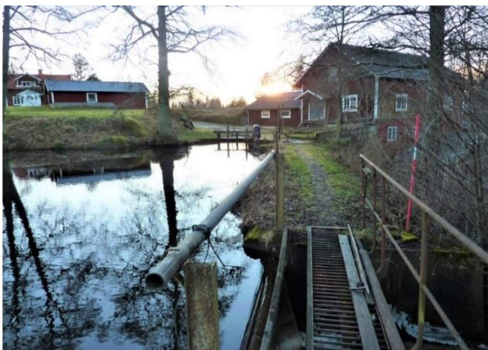
Figur 21. Konungsö kvarn och kraftverksdamm med kvarnbyggnad.
