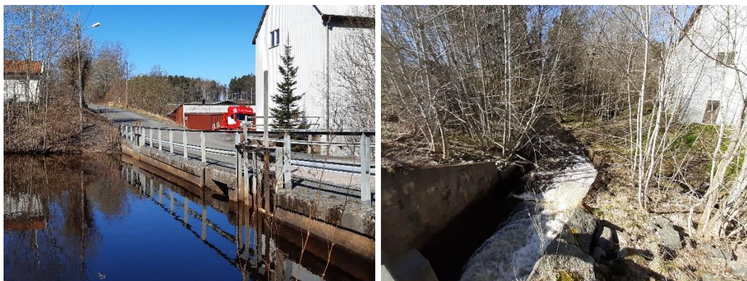
Figur 10. I vänster. Dammfästet vid Hellstorps kvarn med kraftstationen synlig i bakgrunden. Figur 11. I höger. Utskovskanal vid Hellstorps kvarn. (Foto: Länsstyrelsen 2021-04-16.)
