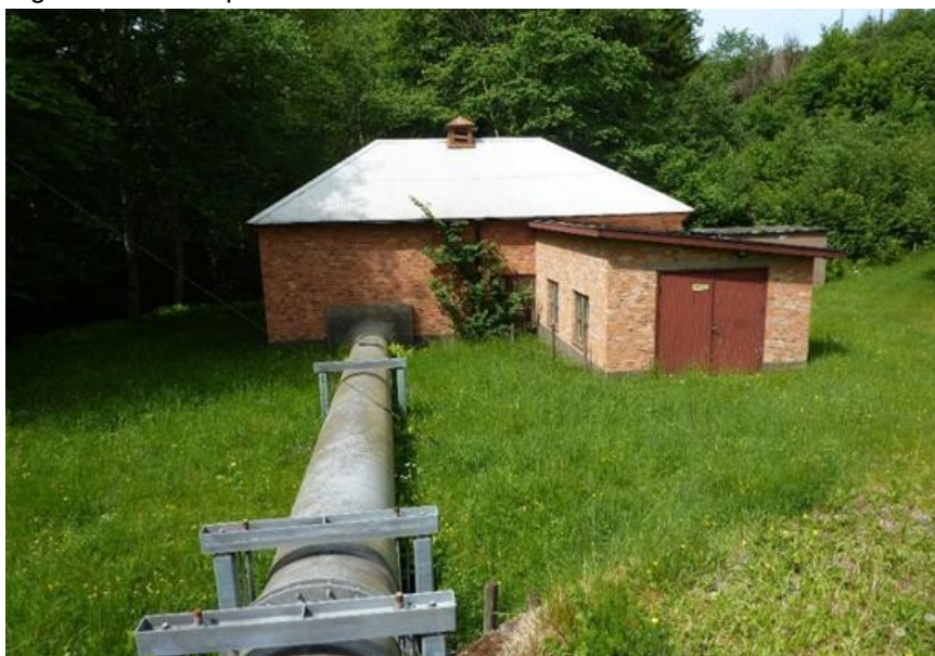
Figur 27. Hällstorps Nedre kraftstation med tilloppstub
