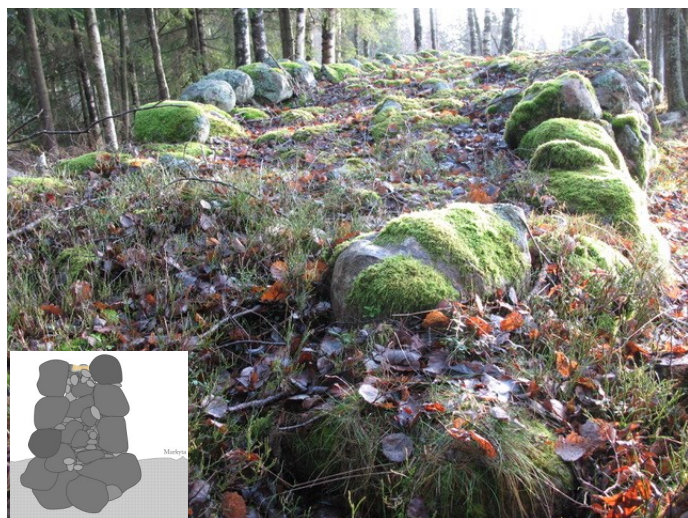
Skalmur, de grövre blocken på vardera sidan bildar skalet på muren. Plocksten från åkern ligger i mellanrummet.
