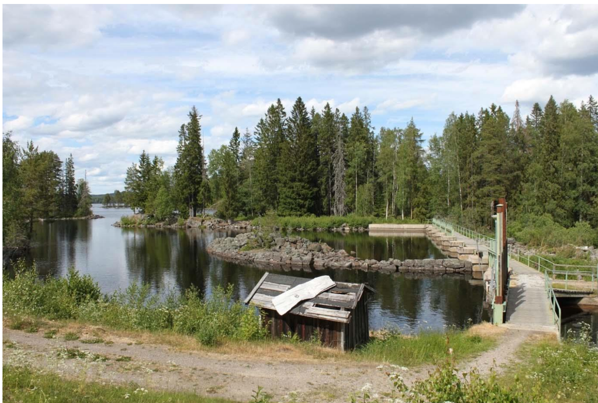
Bild 6. Storsjöns regleringsdamm mellan Storsidran och Lillsidran. Dammbassängen och dammvallen med inloppskanalen i förgrunden till höger.
