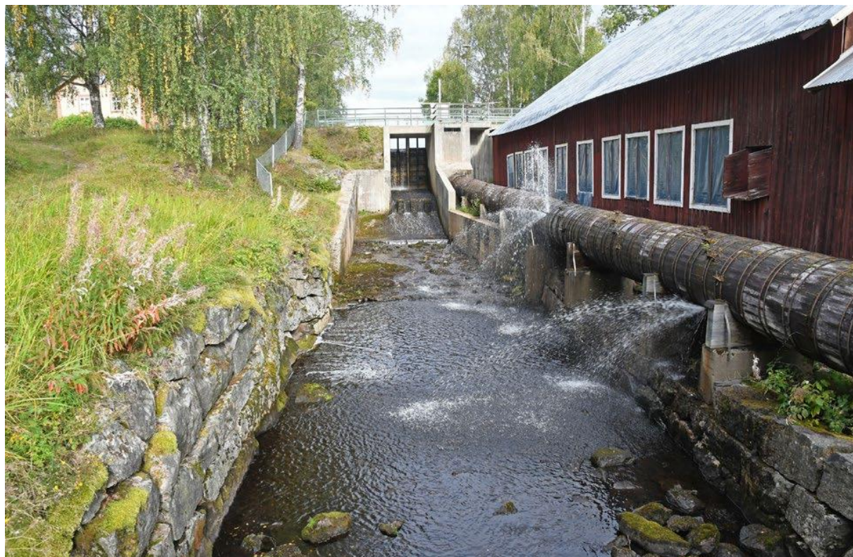
Bild 7. Strömbacka bruks övre damm med den stensatta kanalen. Övre hammaren och vattentuben till höger i bild.
