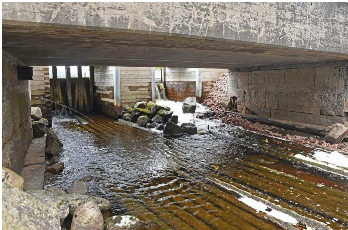
Bild 9. Lennsjödammens brofundament av huggen sten, stensatta timmerkistor och skibord av rundvirke.
