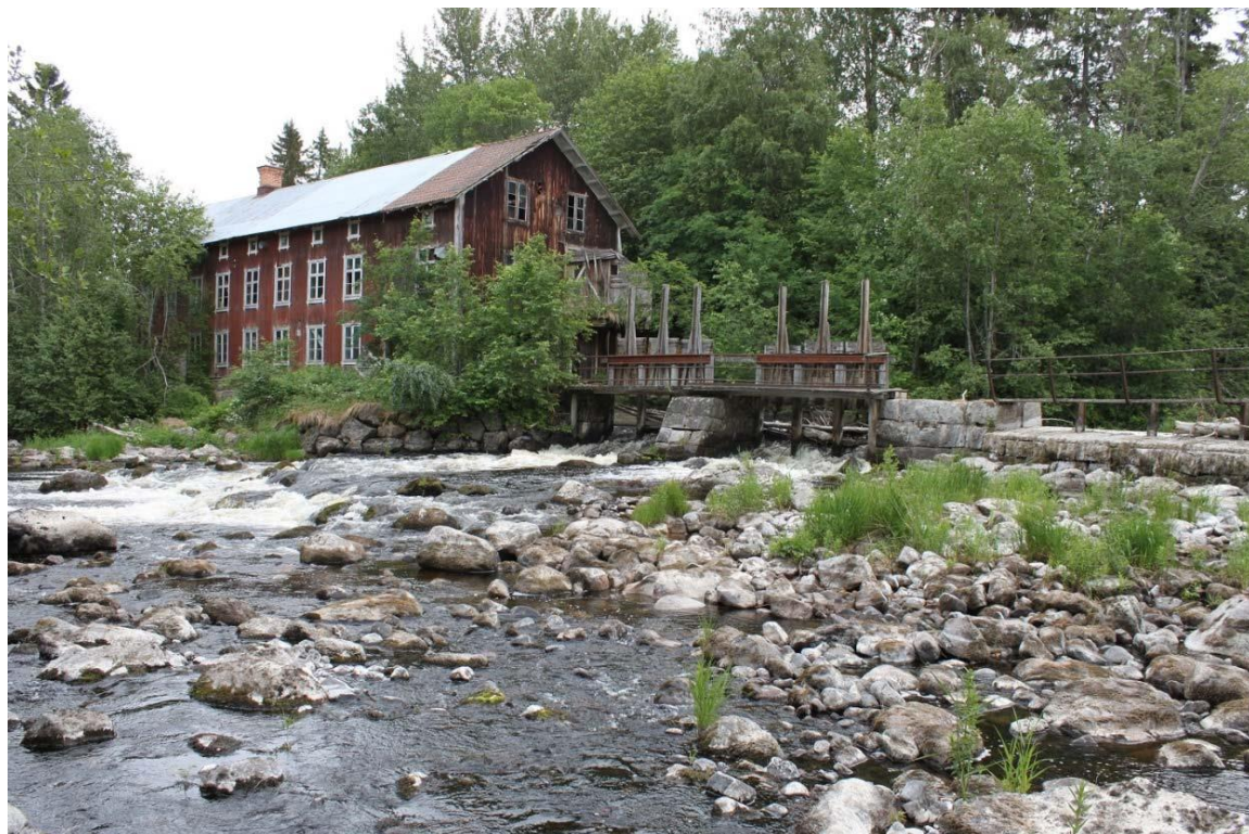
Bild 4. Forsa mellersta kraftverk/Forsa kvarn med dammluckor och dammvallsfundament.
