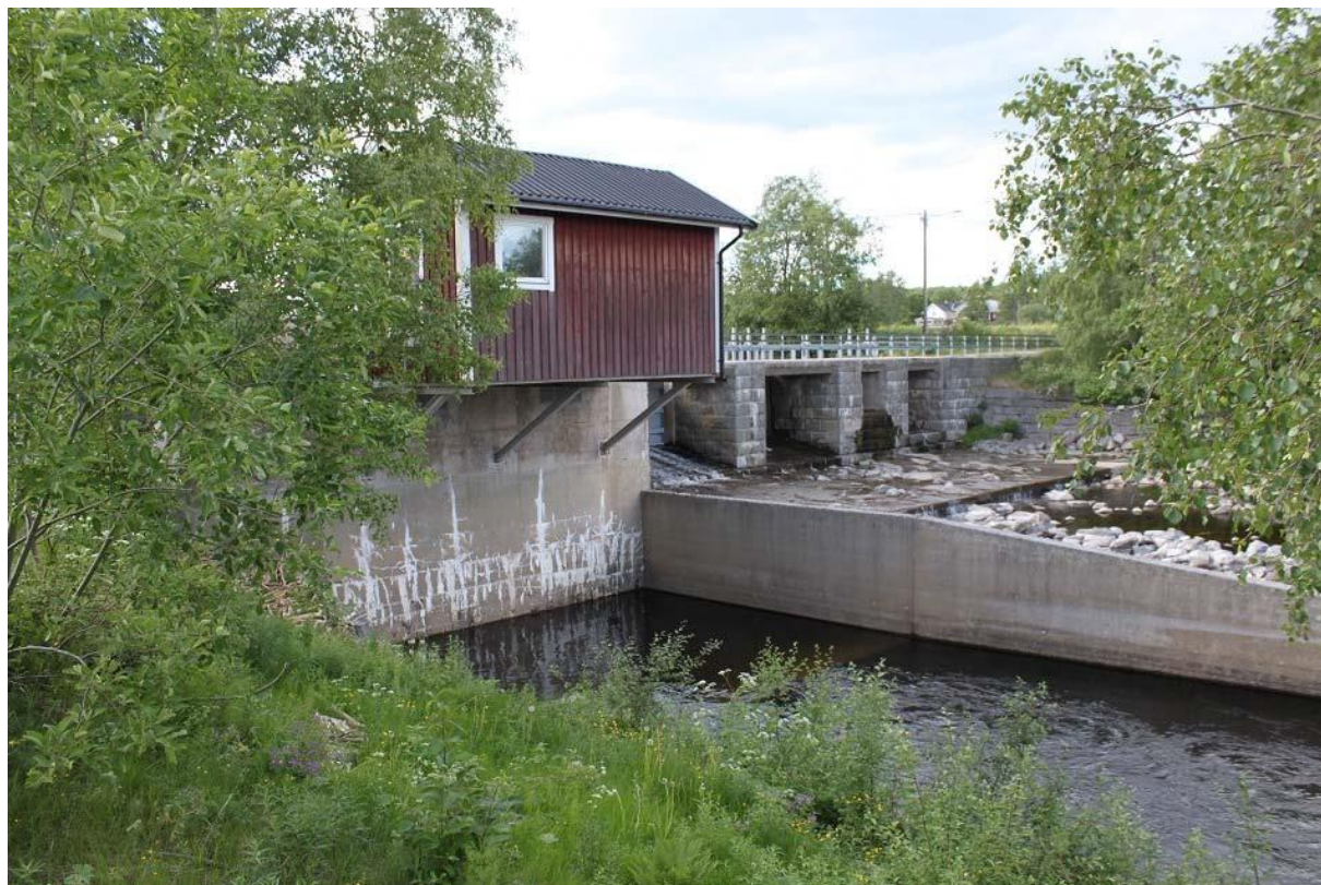
Bild 3. Forsa nedre kraftverk med utlopp av gjuten betong. Dammvallens stenfundament och den stensatta sidan av ån till höger i bild.
