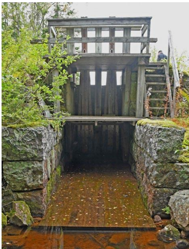
Bild 8. Utskovet vid Skäråssjön av kallmurad sten med spettluckor och skibord av trä.
