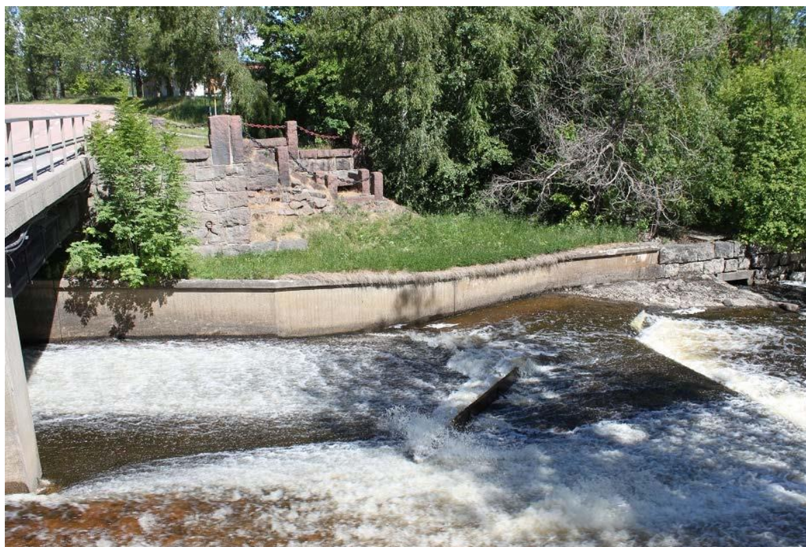
Bild 2. Gjutna sidor av ån närmast Hammarbron, nedströms är sidorna stensatta. Stentrappan ledde tidigare till en park på norra sidan av ån. Till höger i bild, där stensättningen börjar, finns öppning till fisktrappa.
