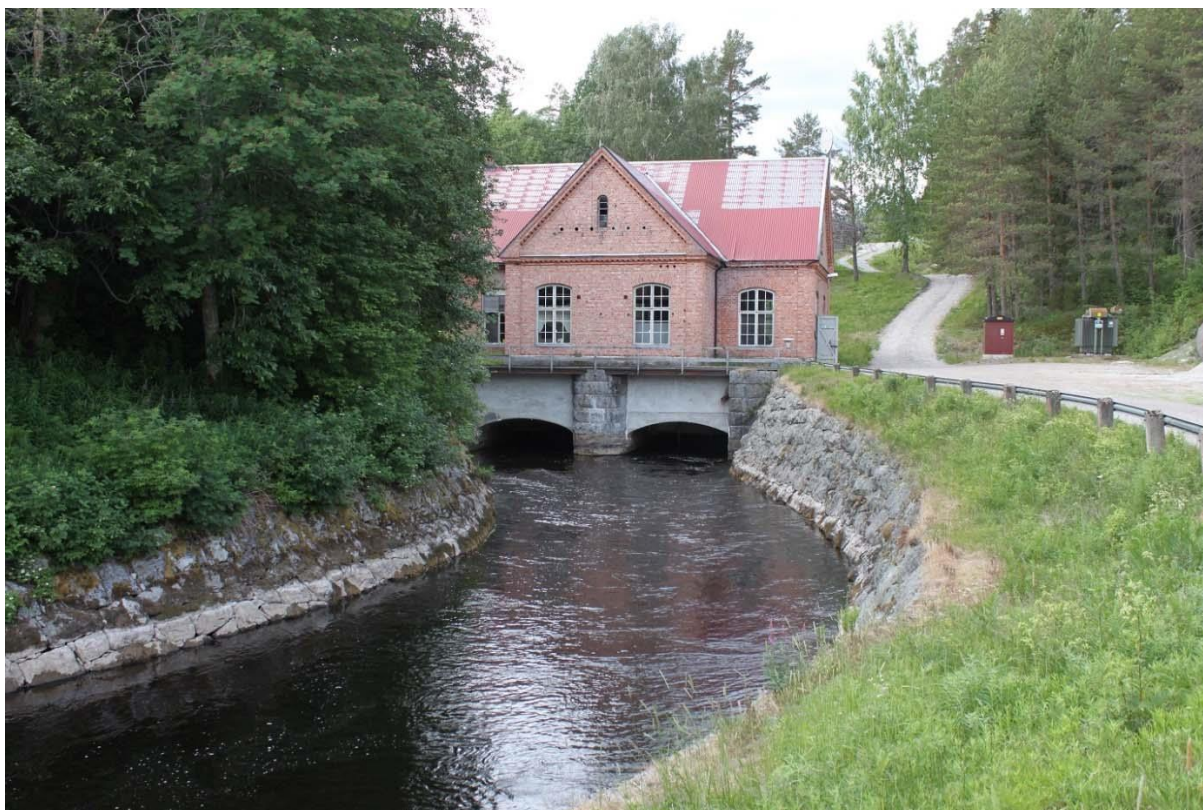
Bild 5. Forsa övre kraftverk med den breda stensatta utloppskanalen.
