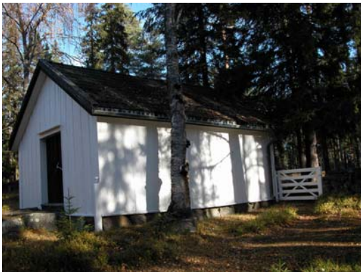
Likkboden på gamla kyrkogården på Näset är en rektangulär fönsterlös byggnad med sadeltak. Brädfodringen består av en dubbelspontad lockpanel och taket är belagt med betongtegel. Byggnadsår är okänt. Foto: Anders Nordström/Västerbottens museum, 2003
