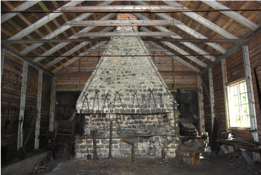
Figur 3. Härden av slaggtegel längst in i byggnaden. Till höger en blåsbälg, till vänster ett vattenhjul. Foto: Ulrika Jansson, Länsstyrelsen i Dalarnas län.
