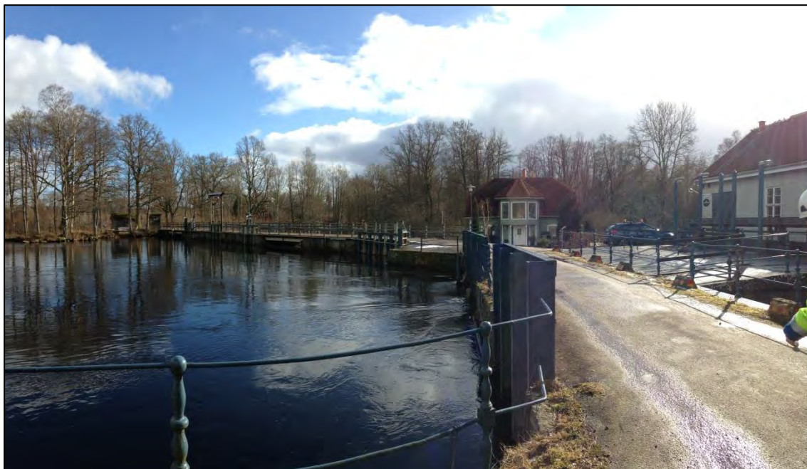
Bild 1. Ohs kraftstation till höger i bild och dammen med dammbyggnad till vänster.
