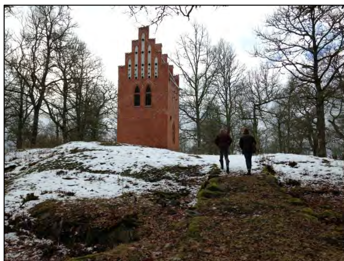
Bild 15. Transformatorstationen i tegel.
