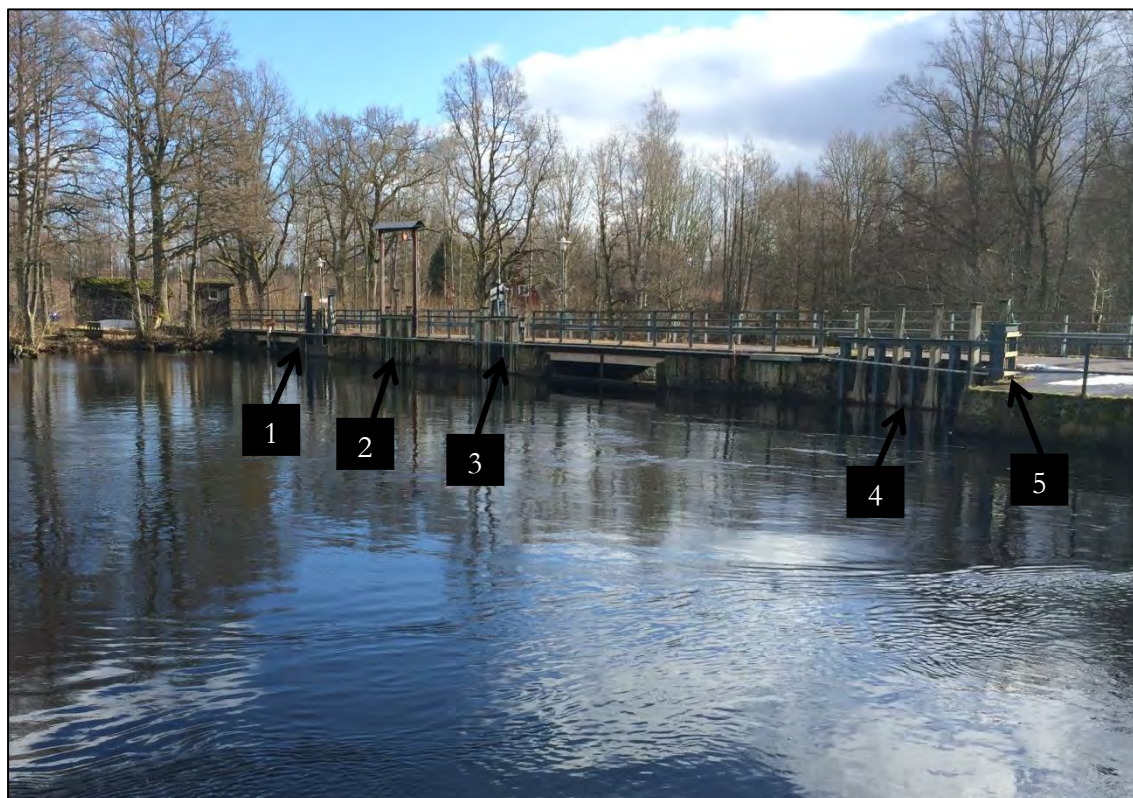
Bild 2. Utskoven vid Ohs kraftstation.
