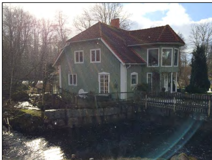
Bild 12. Den ombyggda före detta maskinistbostaden.
