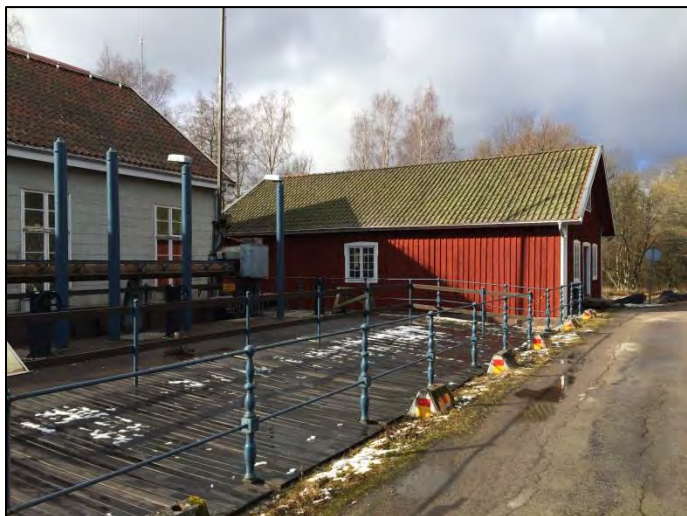
Bild 9. Kvarnbyggnaden med kraftstationen t.v. i bild.
