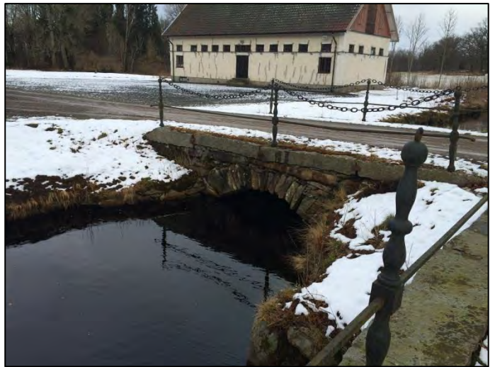
Bild 7. Stenvalsbro vid dammen.
