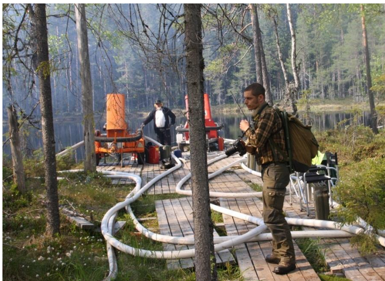
Pumpar på träbrygga som byggdes för att skydda myren. Foto: Egon Jacobsson.
