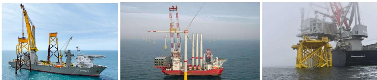
Figur 12. Installation och demonteringsfartyg, fackverksfundament, vindkraftverk och havsbaserad Transformatorstation.
