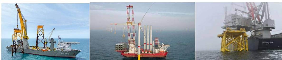
Figur 14. Installation och demonteringsfartyg, fackverksfundament, vindkraftverk och havsbaserad Transformatorstation.
