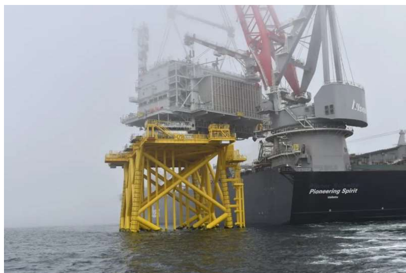
Figur 7.2-Anläggning av havsbaserad transformatorstation – Tunglyftsartyg
