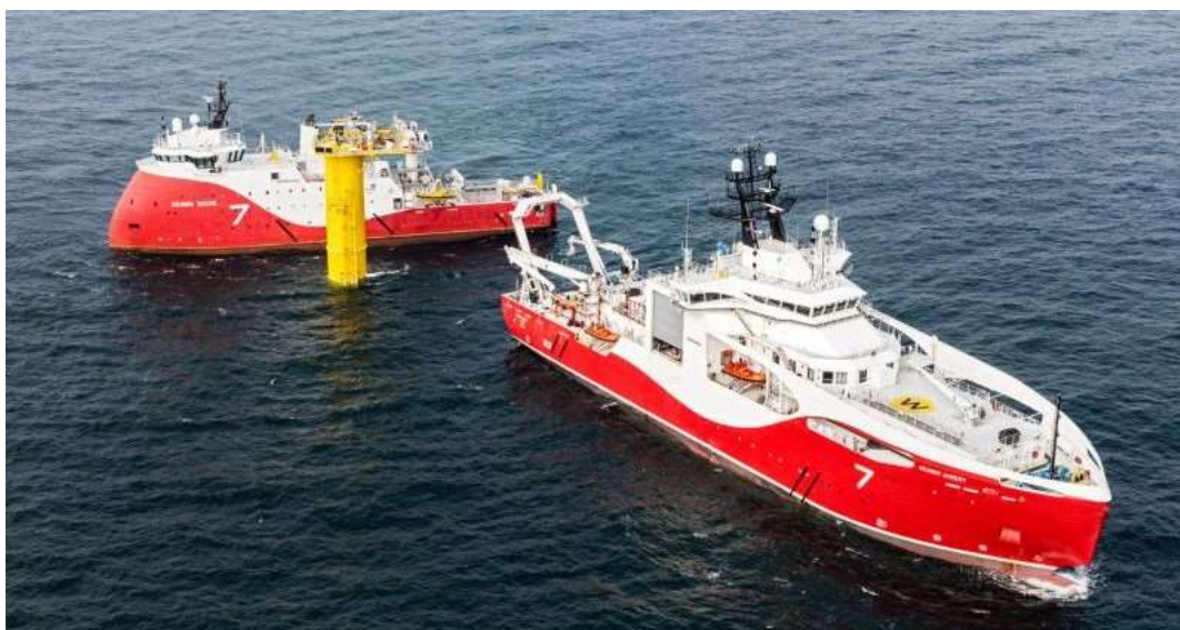
Figur 5.5-Kabellägningsfartyg (till höger) och stödfartyg (till vänster) i anslutning till ett fundament
