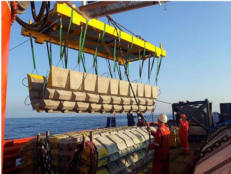
Figur 5.9-Betongmadrass och ett installationsverktyg
