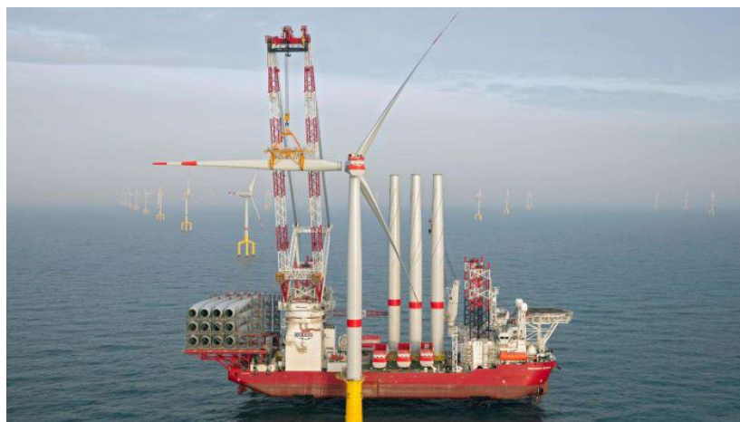
Figur 7.1-Vindkraftverk – Anläggningsfartyg
